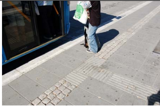
Bilde 148 Porsgrunn busstasjon. Ledelinje midt på gangareal utført i smågatestein. Fungerer ikke etter intensjonen fordi den oppfattes som snublefelle. Her bør det være kunstig ledelinje.
