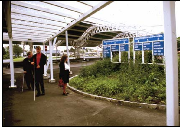
Bilde 155 Flåtevær, Haugesund. Her er det et tydelig skilt med store bokstaver. For synshemmede er det likevel en fordel å kunne gå helt inntil. Beplantningen foran skiltet hindrer derfor noen passasjerer i å kunne lese skiltene.
