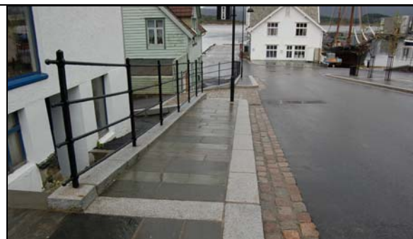
Bilde 33 Florø sentrum. På fortauene er det brukt mye skifer. Skifer blir lett glatt i regn og snø. Her er dette kompensert ved å bruke rekkverk opp bakken. Skifer kan også gi refleksjoner og gjenskinn når det er vått, som igjen kan gi en blindingseffekt.
