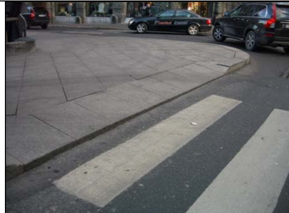
Bilde 86 Oslo, Akersgata. Dette er en eldre løsning med nedramping med granittheller. Denne blir ofte unøyaktig og for bratt. I tillegg er det for stort nivåsprang på svært mange av disse løsningene. Her mangler det varselfelt, men den bratte nedrampingen er lett merkbar så løsningen kan være brukbar for synshemmede når en bare finner overgangen. På flaten rundt er det meste lys grått med små kontraster.
