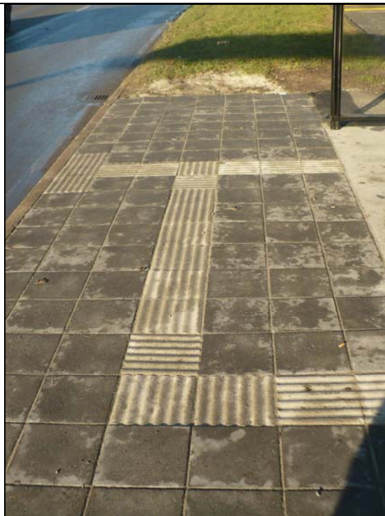
Bilde 144 Porsgrunn. Detalj av ledelinjer og belegg på holdeplass
