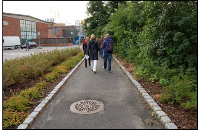
Bilde 32 Gangveg, Porsgrunn. Gangvegen har gode kantmarkeringer av storgatestein med viskant på 4-5 cm.
