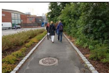
Bilde 27 Gangveg ved kjøpesenteret Down Town, Porsgrunn. God visuell og taktill avgrensning av gangveg ved bruk av storgatestein og grønn rabatt. Kumlokk og avløpsrister bør unngås i gangbanen.
