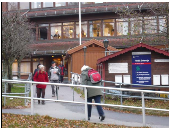
Bilde 68 Oslo, gangveg til eldrester på Oppsal. Her er det rekkverk som gir støtte til personer med problemer med å gå og som fungerer som ledelinje både når det er bart og når det er snø.
