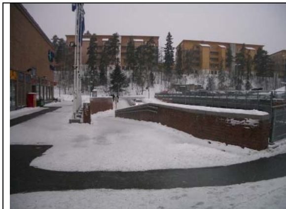
Bilde 118 Oslo, Mortensrud T-banestasjon. Rampe med håndlist i to høyder. Rampen har imidlertid maksimal stigning uten repos, og på grunn av den store bredden på rampen blir håndlisten ensidig.
