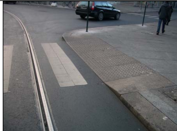
Bilde 85 Oslo, Kirkeristen. Det er mange ulike utførelser, selv innen et område som Oslo sentrum. Her er en av de nyeste med ordinær nedramping i granitt med varselfelt. Det er ikke nivåsprang, og det er ikke oppmerksomhetsfelt som angir gangfeltet.
