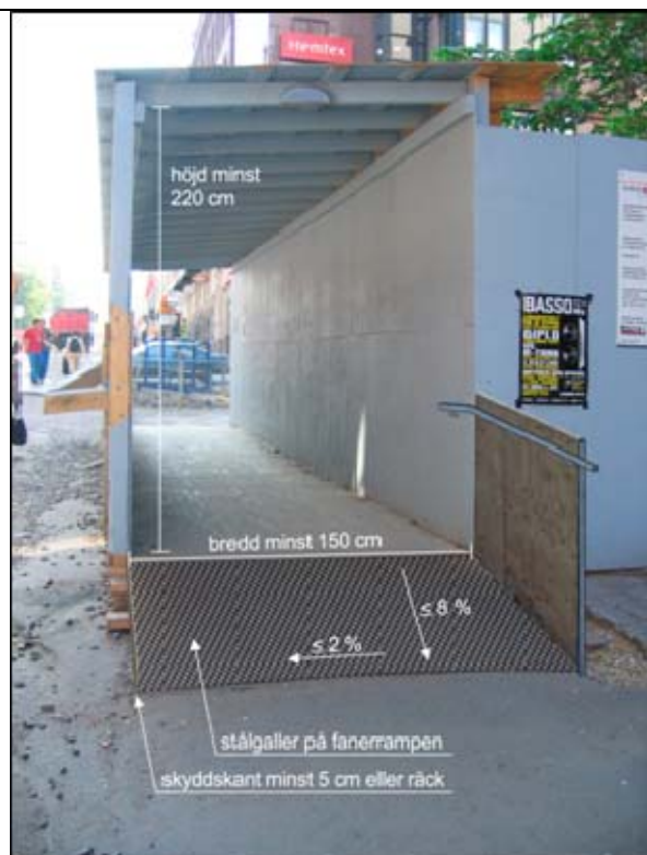
Bilde 165 Helsingfors kommune. Eksempel på informasjon om krav ved anleggsarbeid
