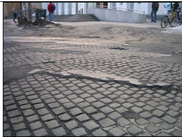
Bilde 1 Sentrum, Oslo. Ujevnheter gir problemer for mange med gangvansker. Det blir også vanskeligere å lese hvor gangfeltet går og hvor det er slutt.
