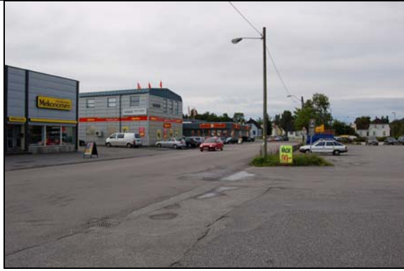
Bilde 20 Skippergata, Porsgrunn. Eksempel på utflytende, gatemiljø med store parkeringsarealer. Slike har ofte store asfaltflater med en blanding av biltrafikk, gående og parkering, der overgangene er uklare. Fortauet er usammenhengende med mange kryssende avkjøringer uten ledelinjer.
