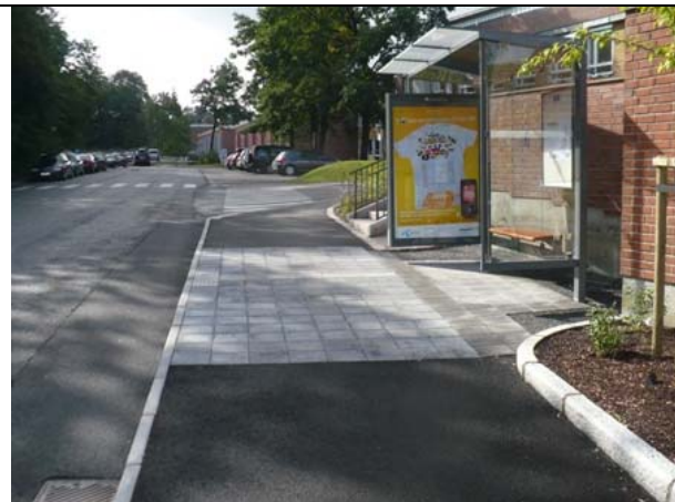
Bilde 143 Porsgrunn. Holdeplass ved sykehuset. Hele holdeplassen er tydelig når det er lagt heller og ledelinjer. Det er også tydelig naturlig ledelinje som fører fram til holdeplassen.
