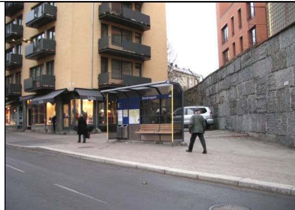
Bilde 139 Oslo. Eksempel på holdeplass som mangler avgrensning bak. Avgrensningen bør gå i bakkant av lehuset, vegg på bildet er for langt bak.
