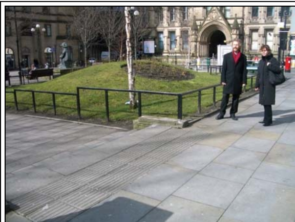
Bilde 112 Manchester, Storbritannia. Utendørs trapp med taktill merking oppe og nede. Etter norsk valg av ledelinjemønster, bør det imidlertid være varselfelt (knopper) i feltet
