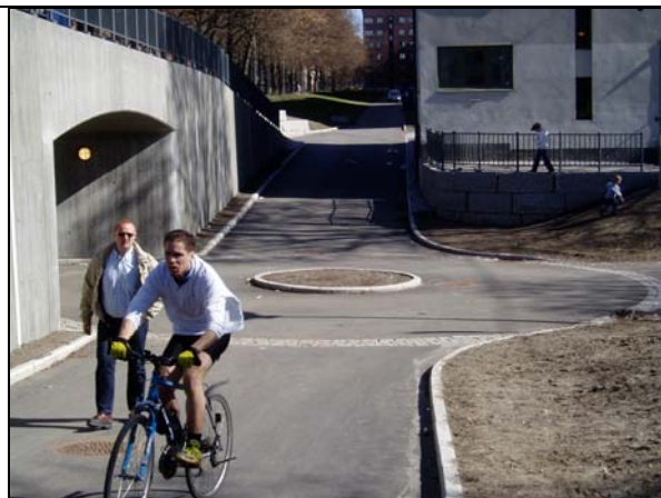
Bilde 101 Chr. Michelsens gate, Oslo. Bred undergang med rundkjøring. I selve undergangen er arealet for fotgjengere og syklister adskilt.
