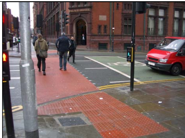
Bilde 95 Manchester, Storbritannia. Varselfeltet angir retning når kantsteinen ikke ligger vinkelrett på gangretningen. Her er det også brukt rød farge på selve fotgjengerfeltet pluss lyse stein langs feltet for å markere retning (i Storbritannia brukes ikke hvite gangfeltstriper som hos oss).
