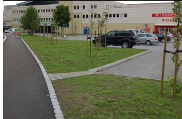
Bilde 21 F. Nansensgate, Skien. Det er ofte de små detaljene som er til størst hinder for tilgjengeligheten. Det er vanskelig å finne trygg veg fra gangvegen over parkeringen til Sparbutikken. En kriseløsning er laget med betongheller oppå gressrabatten.
