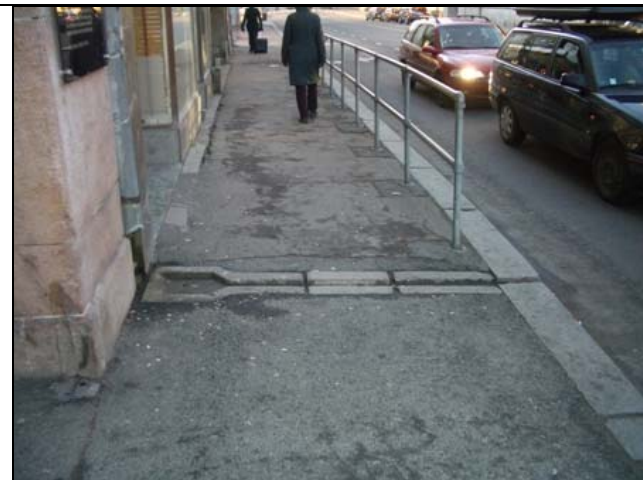
Bilde 81 St. Olavs gate, Oslo. Vannrenner er fortsatt et tilgjengelighetsproblem for bevegelseshemmede med små hjul. Dette er en gammel utforming, og vannrenner kan etableres uten å gi tilgjengelighetsproblemer.
