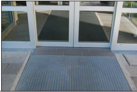
Bilde 54 Skaperist fungerer som et naturlig oppmerksomhetsfelt foran en butikkinngang. En slik metallrist gir også auditiv kontrast.
