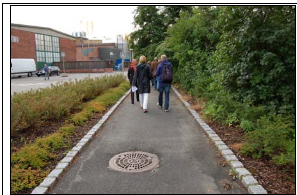
Bilde 69 Porsgrunn. Gangveg med god markering av avgrensning med storgatestein med 4 – 5 cm viskant. En bør unngå kumlokk og avløpsrister i gangarealet.
