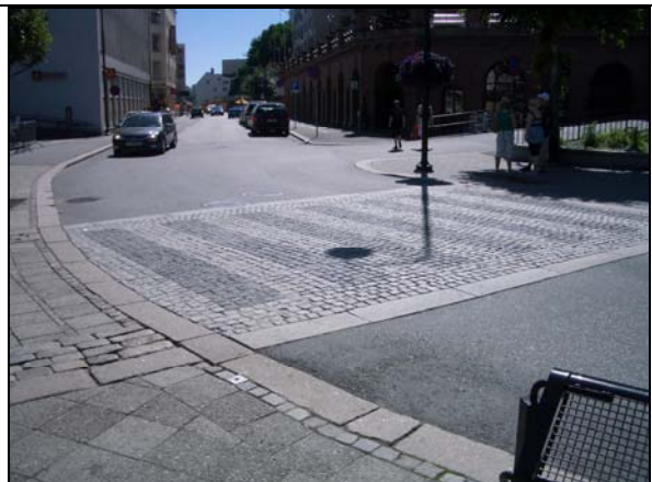
Bilde 2 Sentrum, Arendal. Fint opparbeidede gangfelt, men med ujevnt belegg (brostein) som er ubehagelig for mange med gangvansker. Mange vil trolig krysse ved siden av gangfeltet.
