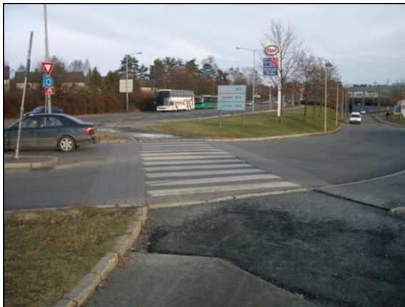
Bilde 75 Alnabru, Oslo. Opphøyet gangfelt i gangveg/fortau over innkjøring til kjøpesenter. Overgangen til kjøreareal er markert med svak nivåforskjell. Her bør det også være varselfelt?
