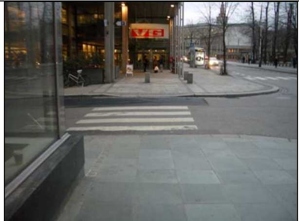
Foto 11- Vado de una rampa tipo "Barcelona" con franja señalizadora central, sin contraste de color con el pavimento circundante
