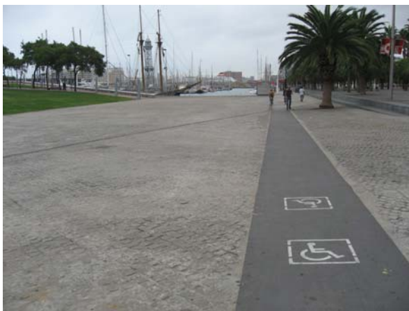
Bilde 70 Barcelona, Spania. Gangarealet over åpen plass er markert med belegg som er lett å gå på og som skiller seg ut både visuelt og taktilt. Dette er en del av en gjennomgående tilgjengelig trase for rullestolbrukere. Symbolet er overflødig.
