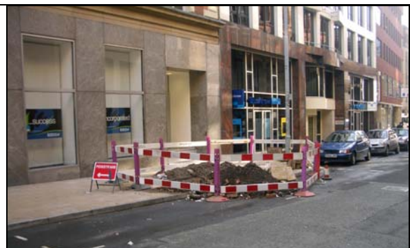
Bilde 34 Manchester, Storbritannia. Varsling ved gravearbeid. Det er tydelig varling i to høyder. Denne kan også oppdages med en mobilitetsstokk.
