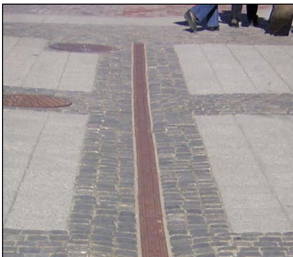
Bilde 56 Sandnes. En avløpsrist ligger i midten av gågata i Sandnes. Denne kan fungere som en naturlig ledelinje.
