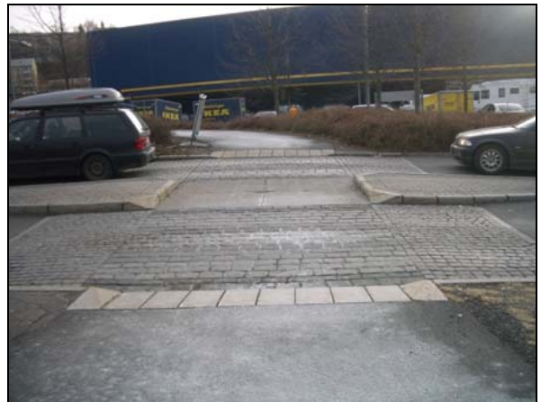
Bilde 76 Alnabru, Oslo. Her er en annen ut- og innkjøring (til Ikea) med halvt opphøyet gangfelt og halvt nedsenket overgang. Det burde for øvrig her ha vært slett stein i selve overgangen, og gatestein i opp- og nedrampingen for bilene. Videre burde det ha vært varselfelt i nedrampingen.
