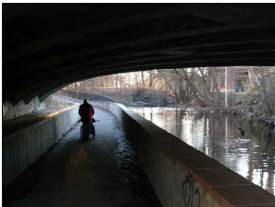
Bilde 67 Oslo, gangveg/turveg langs Akerselva. Gangveien er lett å følge med "rekkverk" i form av flomsikring. Det er også ordinært rekkverk (i bakgrunnen på bildet)
