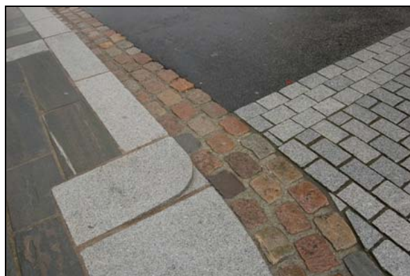
Bilde 97 Florø. God fargebruk i nedsenket kantsten. Men den tredoble rekken med gatestein er ubehagelig med rullestol.
