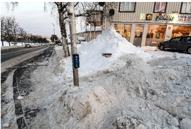
Figur 13. Slik skal det ikke gjøres. Det vil for mange trafikanter være umulig å nå trykknappen (Foto: Knut Opeide, Statens vegvesen)
