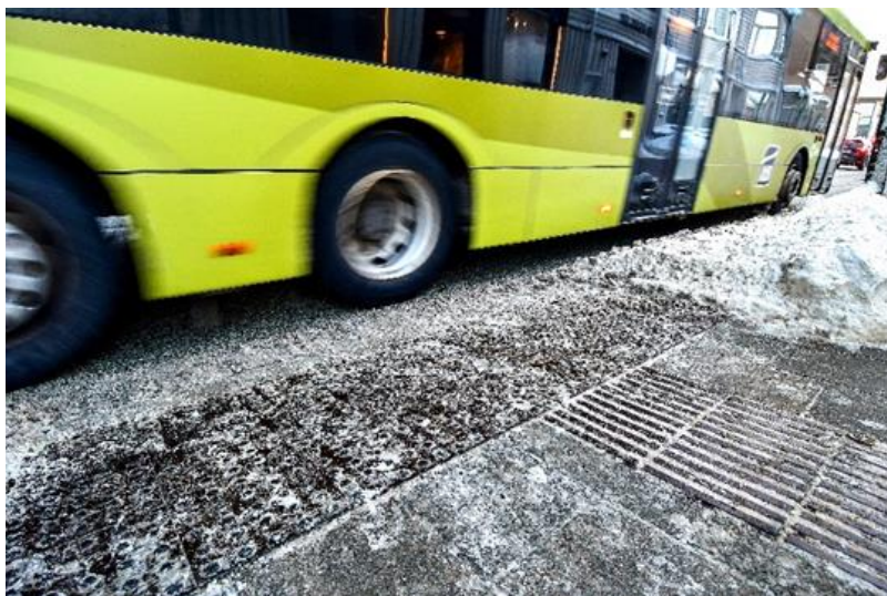
Figur 12. Retningslinje R610 setter krav til at taktile heller holdes snø- og isfrie (Foto: Knut Opeide, Statens vegvesen)
