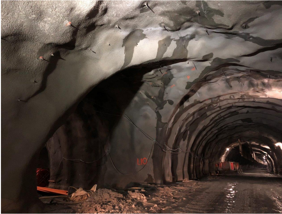
Figur 7.39 Kryssbuene fotografert fra pel 5770 i figur 7.38. (Foto: T. Kirkeby).
