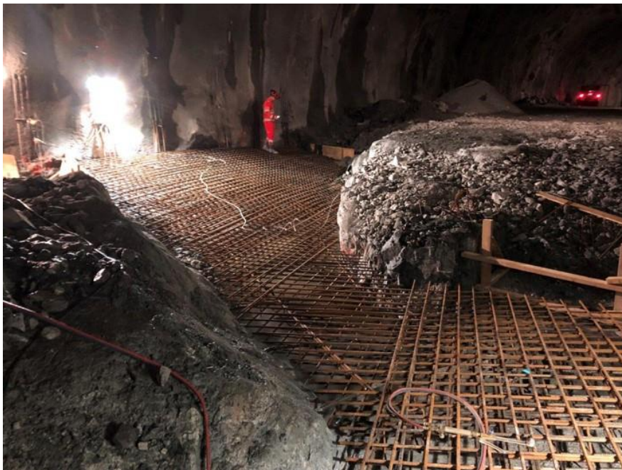
Figur 7.34 Relativt tett armering i bueformet sålestøp avsluttet mot berget utenom sonen. Åpen buearmering kan skimtes i vegg til venstre. Eksempel fra Rv. 580 Søråstunnelen i Bergen 2018. (Foto: T. Kirkeby)
