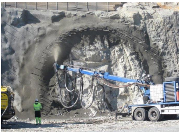
Figur 7.7 To raster med forbolter med 6 m Ø 32 mm, bundet sammen med Ø 16 mm kamstål, innerste rast helt ned mot sålen. Illustrert i skisse til høyre: innerste rast 60-70 cm fra teoretisk sprengningsprofil med innbyrdes bolteavstand c/c 60-70 cm, og en ytre rast 60-70 cm utenfor denne igjen, satt slik at boltene i ytre rast plasseres midt mellom to bolter i indre rast (såkalt W-mønster). Ringveg Vest Bergen, 2. byggetrinn. (Foto: T. Kirkeby)
