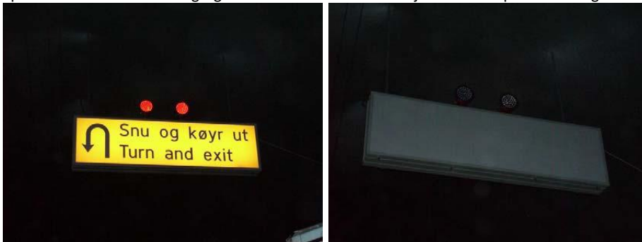
Figur 6.1 Eksempel på skilt og signal for snunisje i tunnel. To-posisjonsskilt vist i aktiv og passiv stilling. [75]
