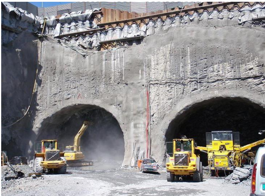
Figur 7.4 Jevn kontur i påhuggsflate. Lørentunnelen (Foto: A. Neby)
