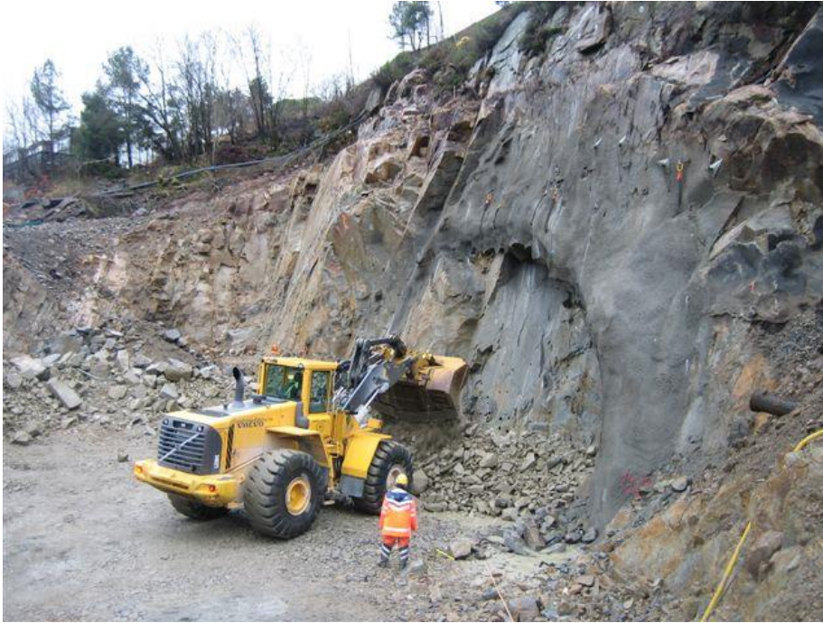
Figur 7.5 Skrått påhugg, flaten står omtrent 45° på tunnelens retning. Påhuggsflaten er også tilpasset markerte sprekkeplan (steilt fall mot venstre). Det er satt en bue med kamstål på forbolter rundt åpningen. Ringveg Vest Bergen, 1.bygetrinn (Foto: T.Kirkeby).
