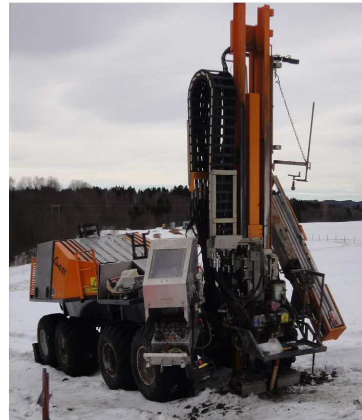
Foto: Frode Oset, Statens vegvesen
