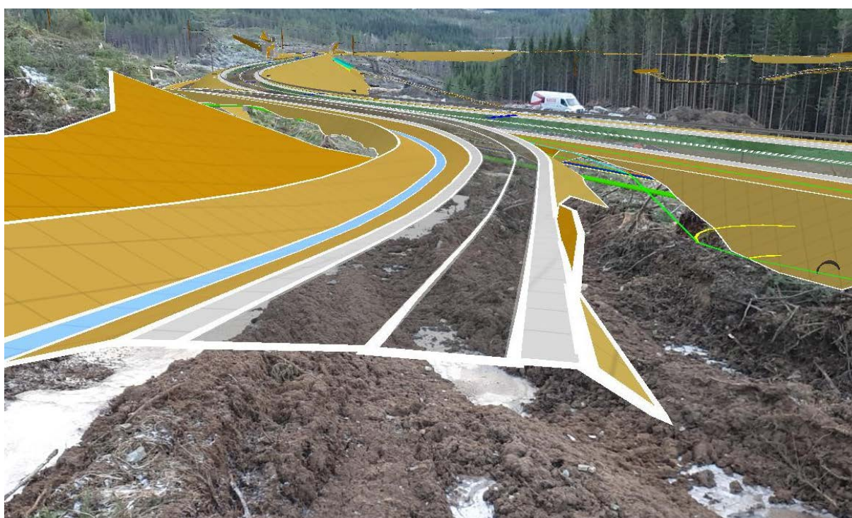
Bruk av Bygningsinformasjonsmodell (BIM) på E39 Betna-Stormyra. Foto: Line Søreng / Statens vegvesen
