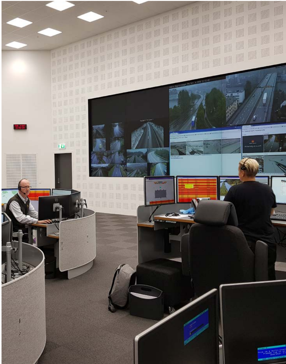
Vegtrafikksentralen i Bergen har styring og overvåkning av ca. 250 tunneler. Hvis det oppstår en tunnelbrann samarbeider flere operatører om å håndtere hendelsen. Foto: Jan Arild Lunde.
