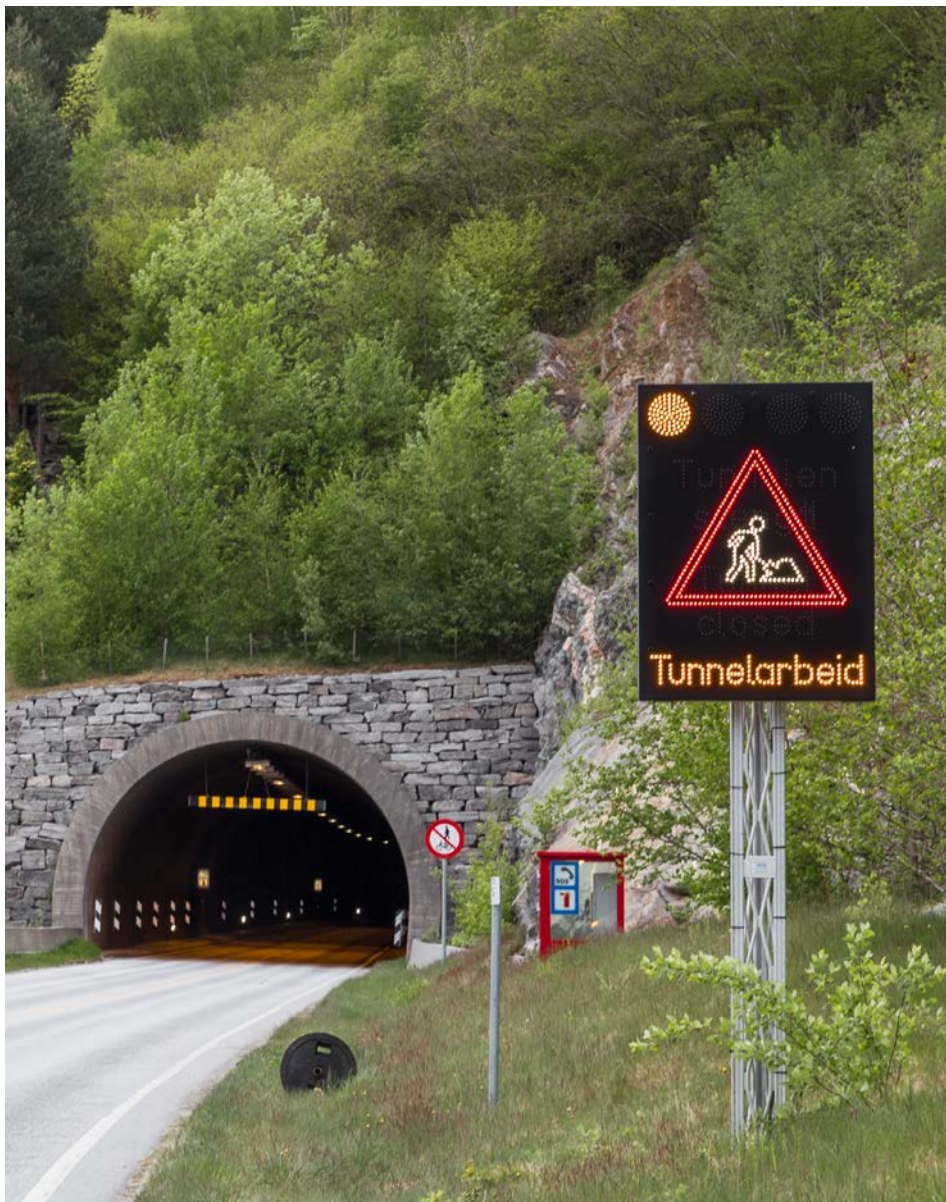
Vegeierne har ansvar for vedlikehold av utstyr langs veg. VTS bistår med stenging av tunneler og testing av sikkerhetsutstyr. Foto: Knut Opeide
