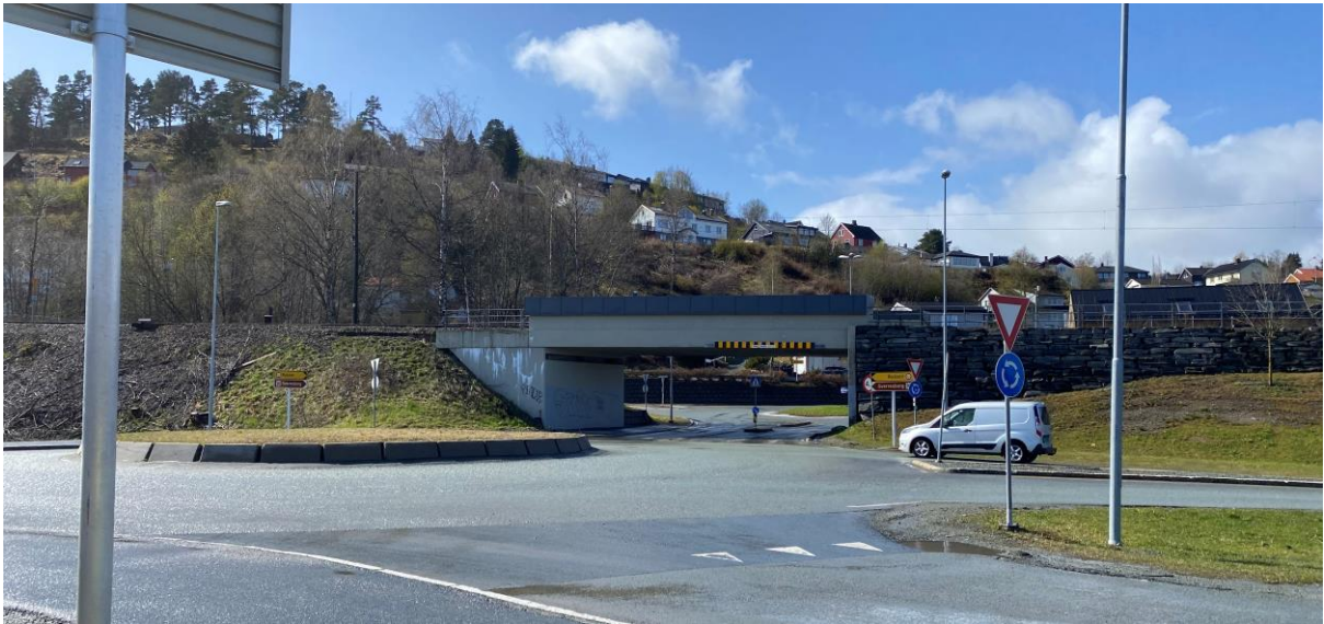
Figur 50: Rv. 706 Osloveien, ved rundkjøringen på Stavne. Jernbanebru. Bildet er sett fra øst.
