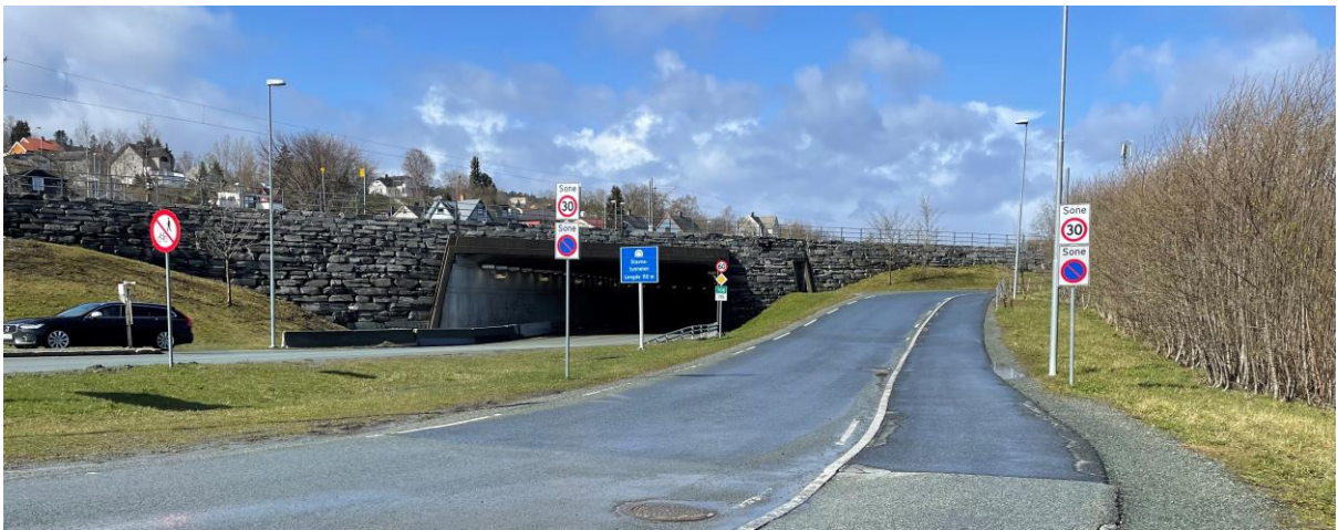
Figur 51: Rv. 706 Osloveien, ved rundkjøringen på Stavne. Portal til Stavnetunnelen og gang- og sykkeladkomst mot Stavne. Bildet er sett fra sør (Foto. Statens vegvesen).
