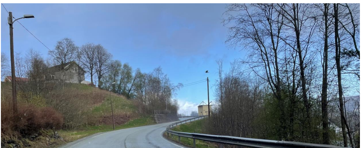
Figur 72: Rv. 706 svinger seg rundt mælen under gårdsanlegget Dorthelyst. Muren langs vegen kan virke skjemmende.
