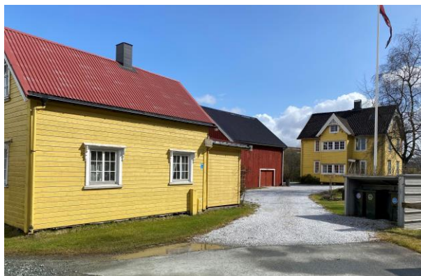
Figur 17: Bygninger med antikvarisk verdi, klasse C tilknyttet Nydalsbruket, Sivert Dahlens veg 1 og 3.
