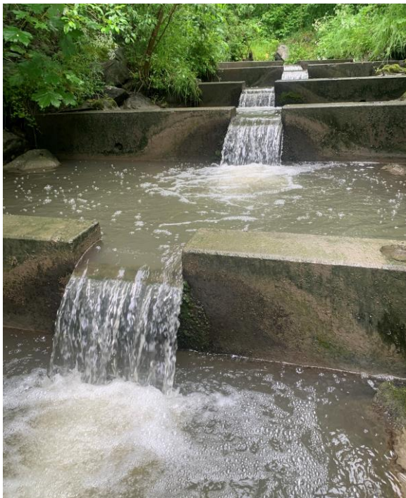
Figur 65 Trappekulper etablert i Sverresdalsbekken
