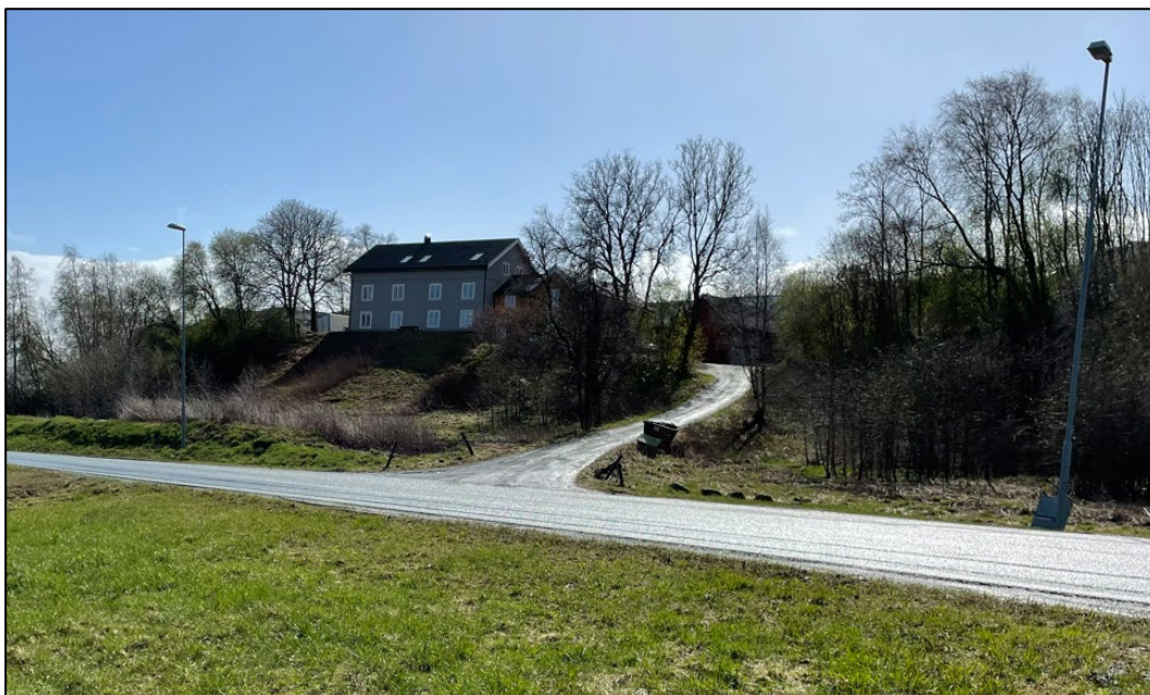
Figur 12 Dorthealyst gård, bygninger fra 1700-tallet med antikvarisk verdi B og C. Mye av bygningsmassen er oppgradert. Gården ligger på vestsiden av Osloveien, mellom riksvegen og jernbanen. (Foto: SVV)
