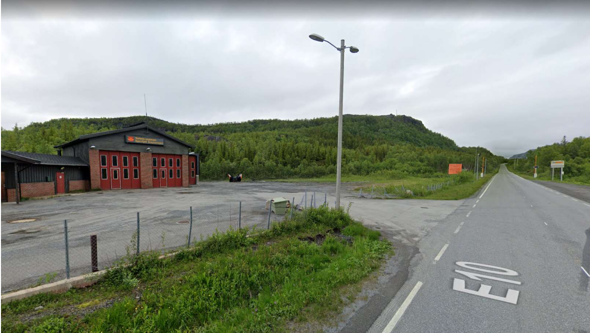
Figur 17. Åspartiet i bakkant av brøytestasjonen, sett mot nordøst (kilde: Google street view).
