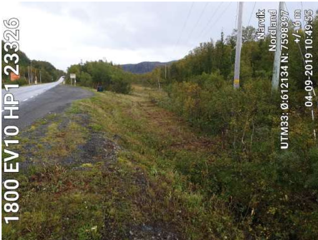
Figur 12. Dagens utfylling på høyre side av vegen, aktuelt areal for etablering av oppstillingsfelt
