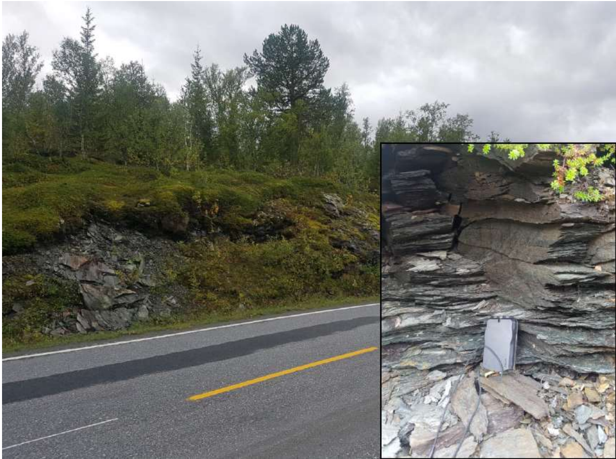
Figur 29. Eksisterende bergskjæring ved Trollvann med strekt forvitret og lagdelt fyllitt/glimmerskifer
