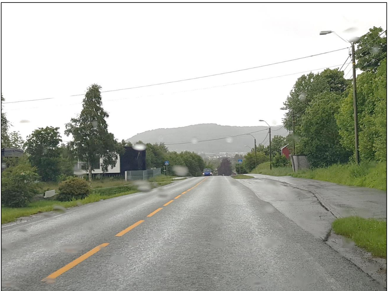
Figur 18 – Bilde tatt 2. juli av «Myrabakken» holdeplass, nordgående retning. Bildet viser typisk utforming av holdeplasser langs den parallelle lokalveien i prosjektavgrensningen «Spjelkavikveien».
