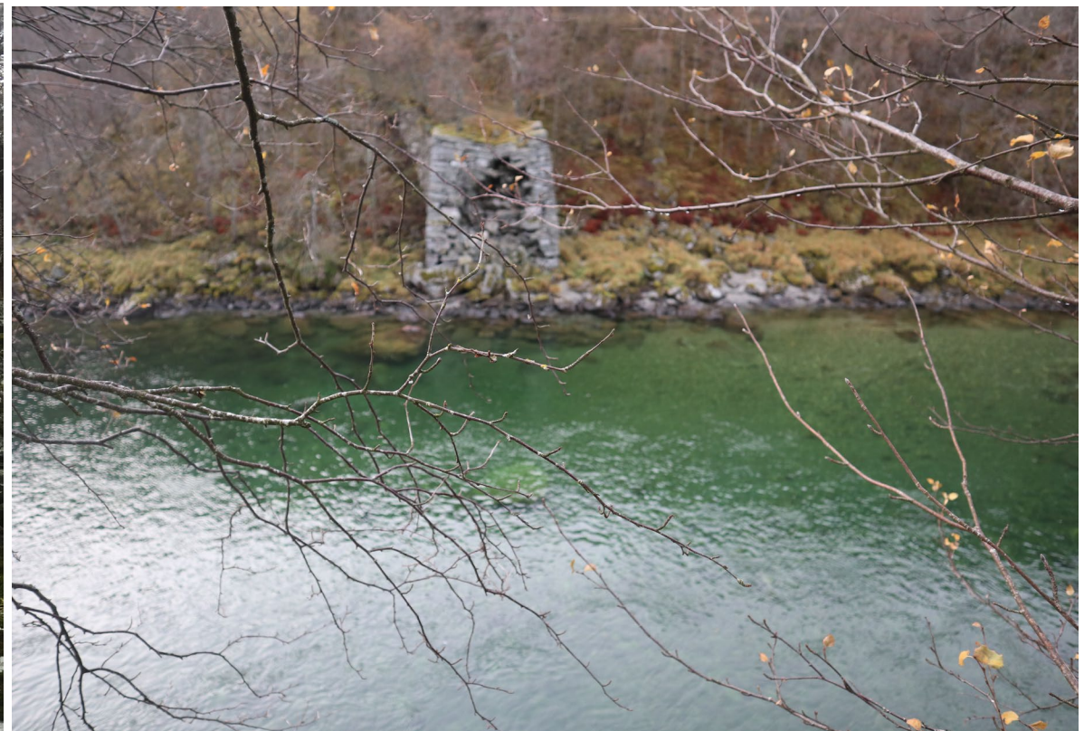
Brufundament (foto Tor Helge Gravem 2021)
