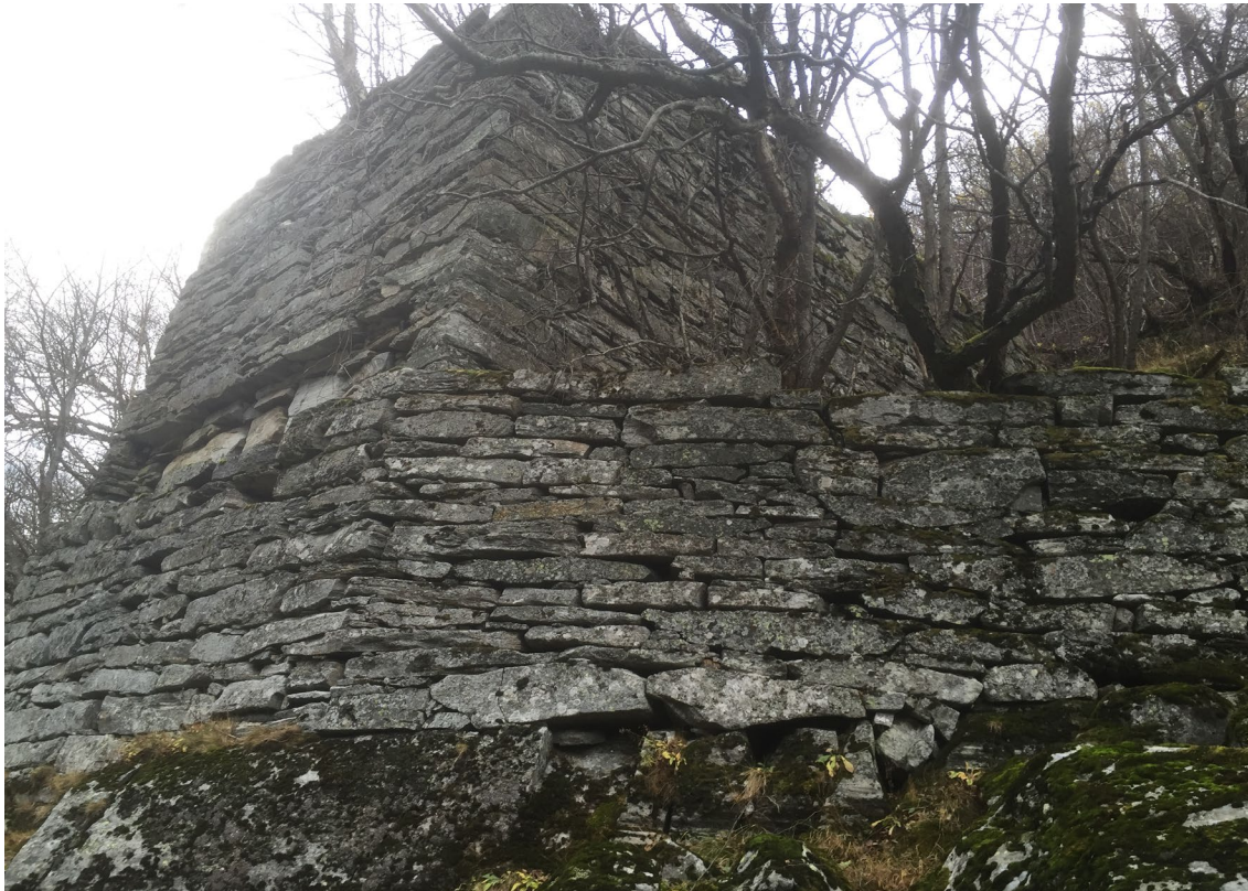
Brufundament (foto Teodor Gravem 2015)
