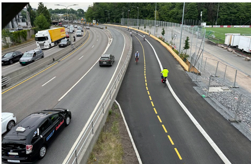
Figur 4: G/S-vei langs E18 mellom Skøyen og Dronning Blancas vei, foto Statens vegvesen.
