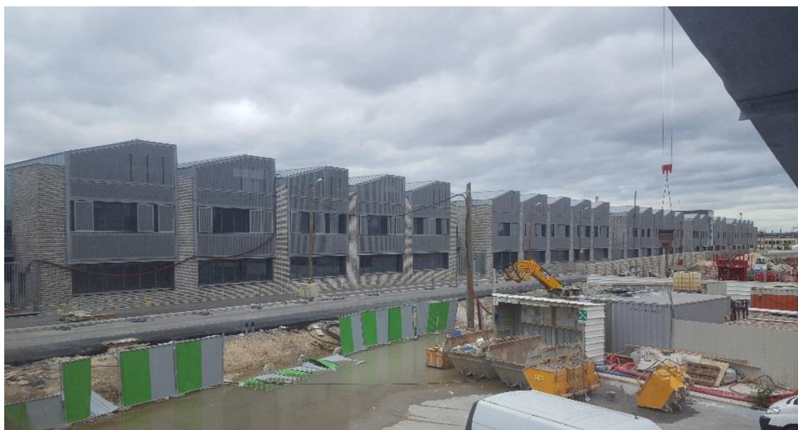
Kontordelen slik den så ut da vi var der. Byggegrøper for boliger i forgrunnen. Nivået foran kontordelen viser bakkeplan.
