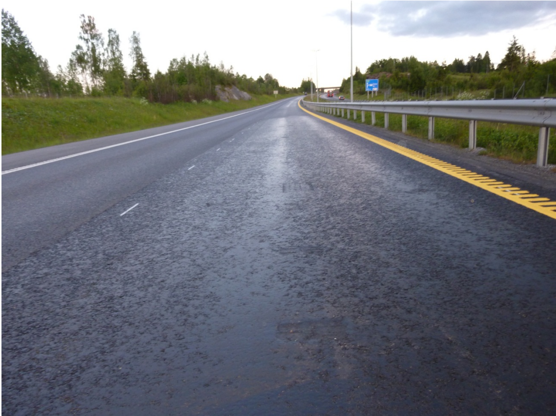
Bilde 1: Ska 16 PMB - ikke optimal sammensetning av masse
