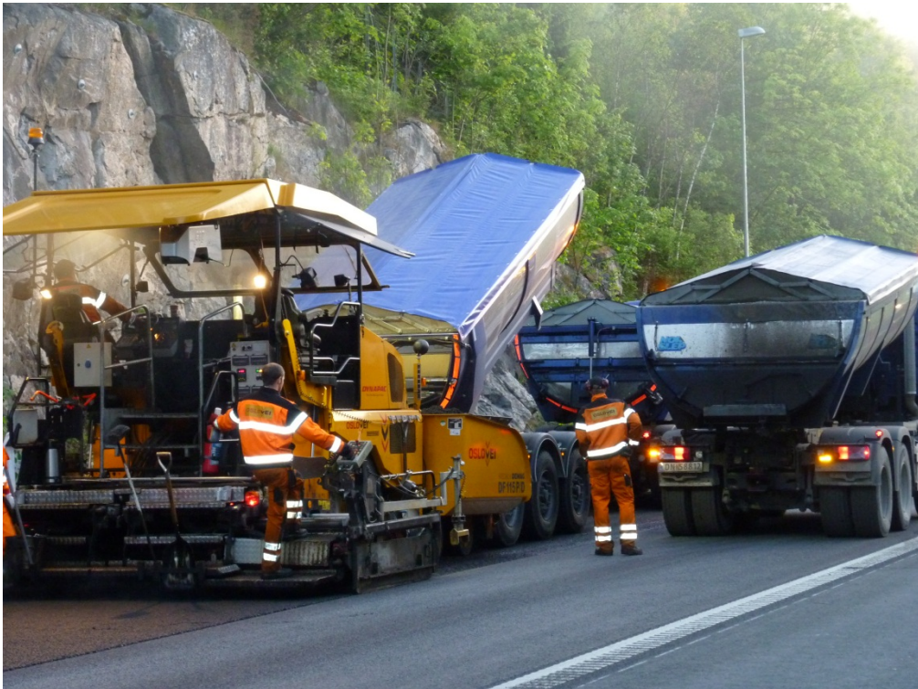
Bilde 4: Utlegging av asfalt
