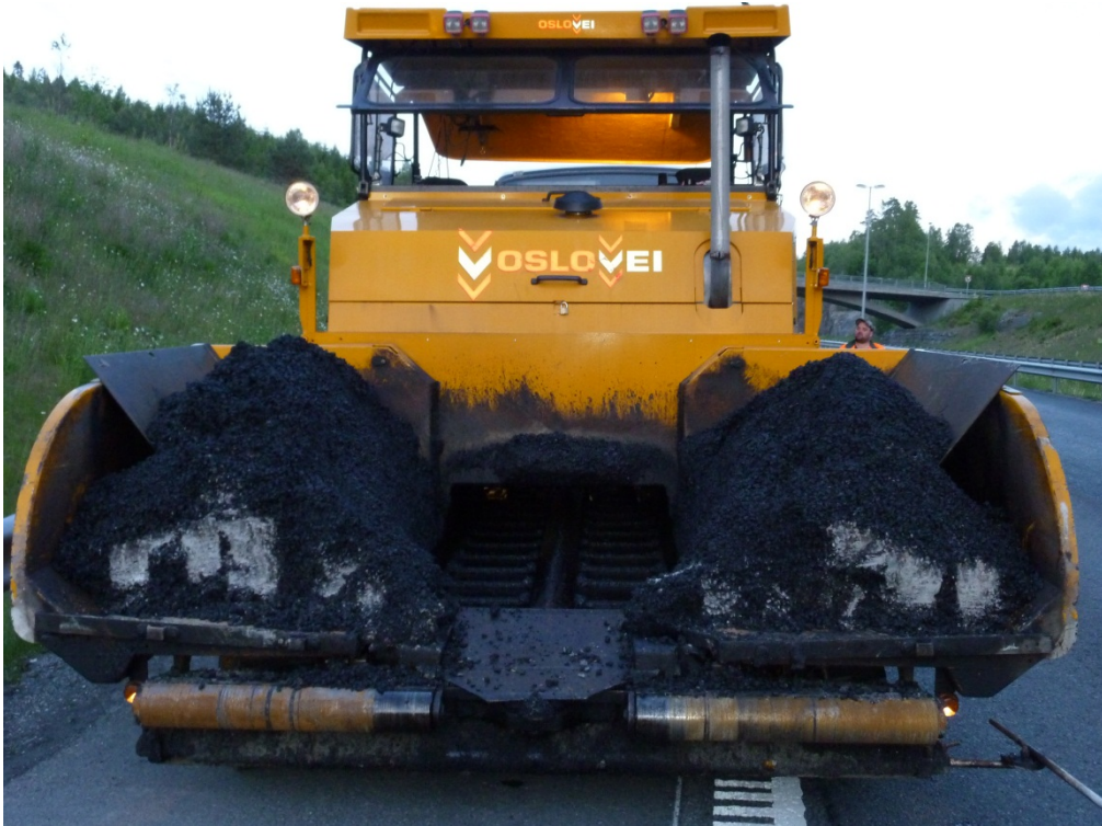
Bilde 3: Avkjølt masse ble liggende i mottakstrau under legging. Vinger ikke slått opp
