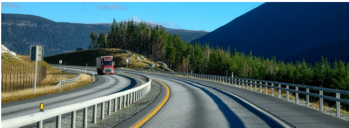
Foto: Knut Opeide, Statens vegvesen
