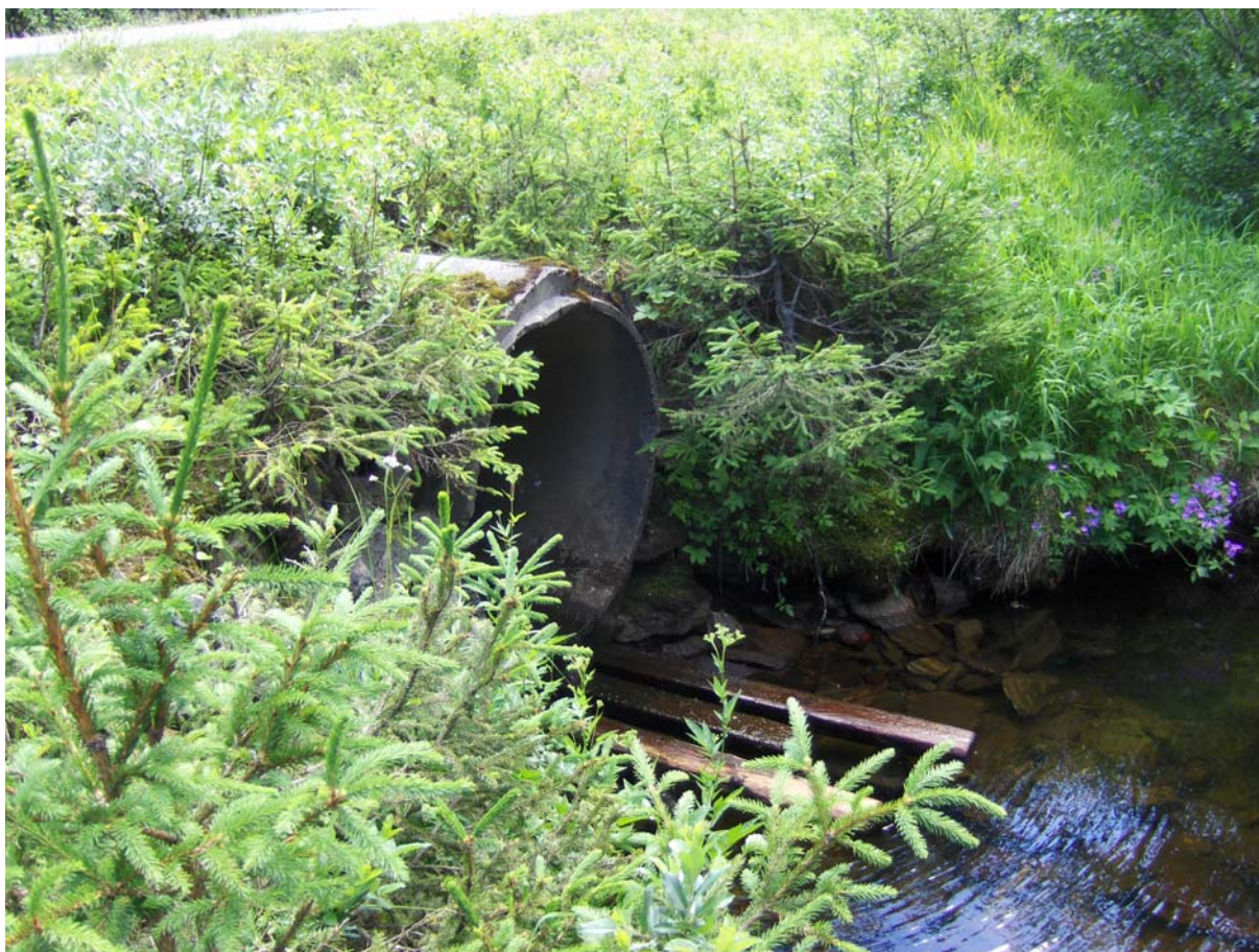
Figur 9: Eksisterende stikkrenne under E6, Budalsbekken.
