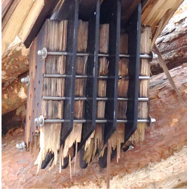
Eksempler på blokkutriving på Perkolo bru
