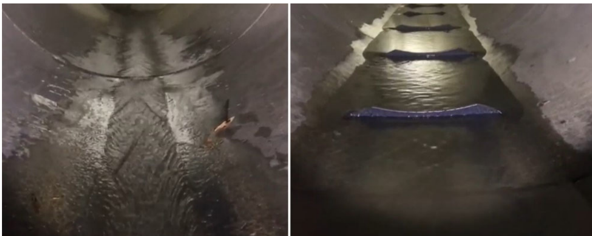
Figur 7. Montering av terskler for å øke vanddybde gjennom kulvert. Foto viser kulvert før (t.v.) og etter (t.h.) installasjon av såkalte "flexi-baffles". Dersom ikke vandring kan foretas på siden av tersklene, kan deler av kulverten «knekkes ned» for vandring over tersklene. Foto er hentet fra Youtube-presentasjon av produktet (se http://www.ats-environmental.com/solutions/culvert-baffles/ ).
