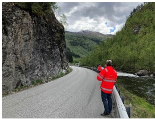
Figur 6 Eksisterande veg går i krapp kurve og med smale og grunne grøfter forbi Kvarmakløvet
