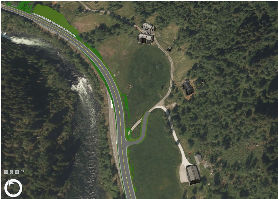
Figur 45 Illustrasjon planlagt veganlegg sør for Skromle bru. Veganlegg er ført innover landbruksareal ved g/brn 312/1 for å oppnå ei meir trafikktrygg veglinje. Det er planlagt for mur for å ta opp sidebratt terreng opp mot busetnad på Humlabrekkehaugen. Avkøyrslar mot Humlabrekke er lagt om for å betre sikt.
