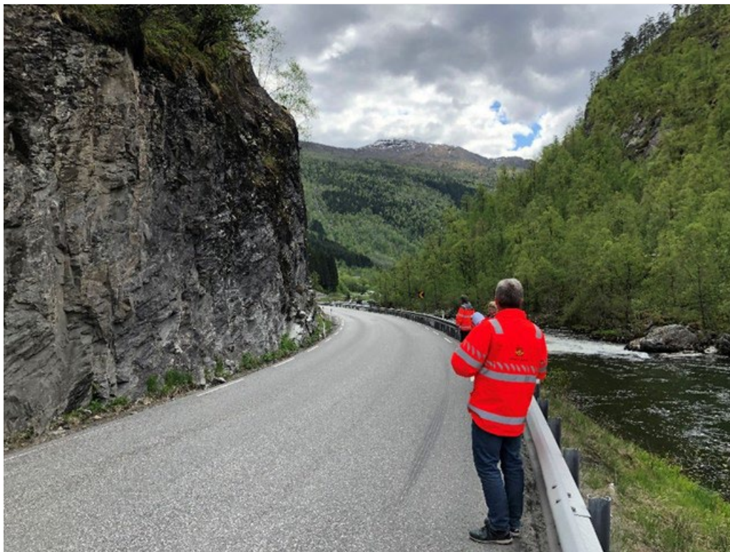
Figur 15 Dagens vegskjering ved Kvarmakløvet. Her må ein sprengje ut 2-3 hyller i fjellet
