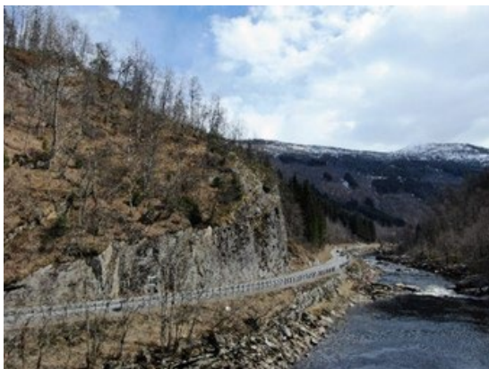
Figur 5 Oversiktbilete over eksisterande skjering Kvarmakløvet
