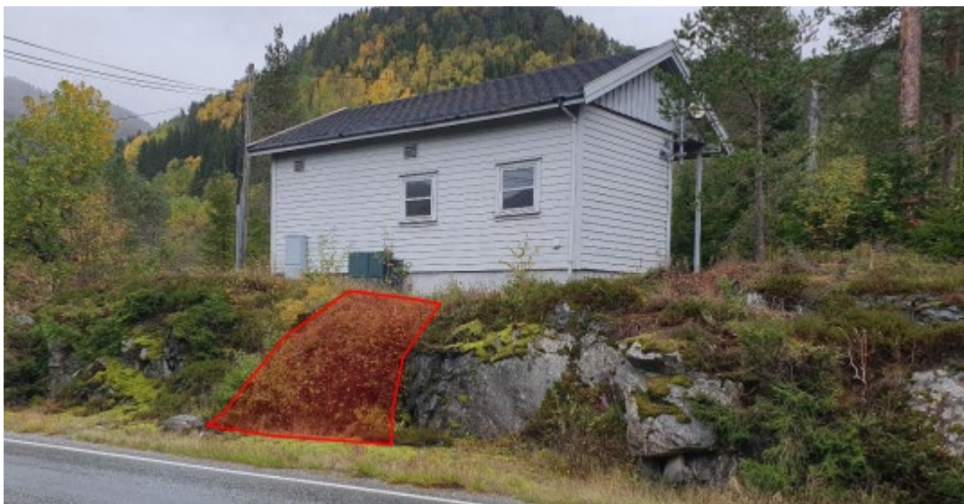
Figur 28 Eksisterande skjering og bygg i nærleik av E16, det vert føresett at det er kabelføring i området med raud markering.
