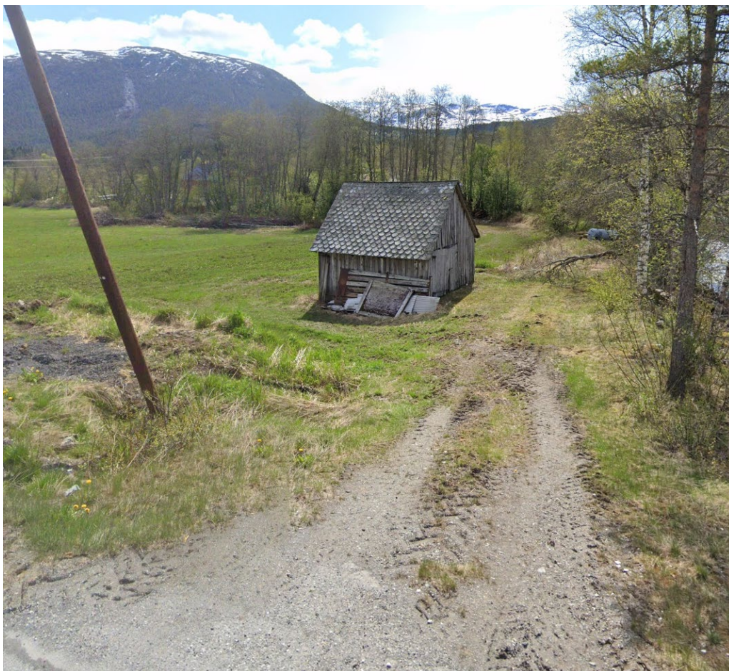
Figur 23 Skiferkledd uteløe ved profil 1400
