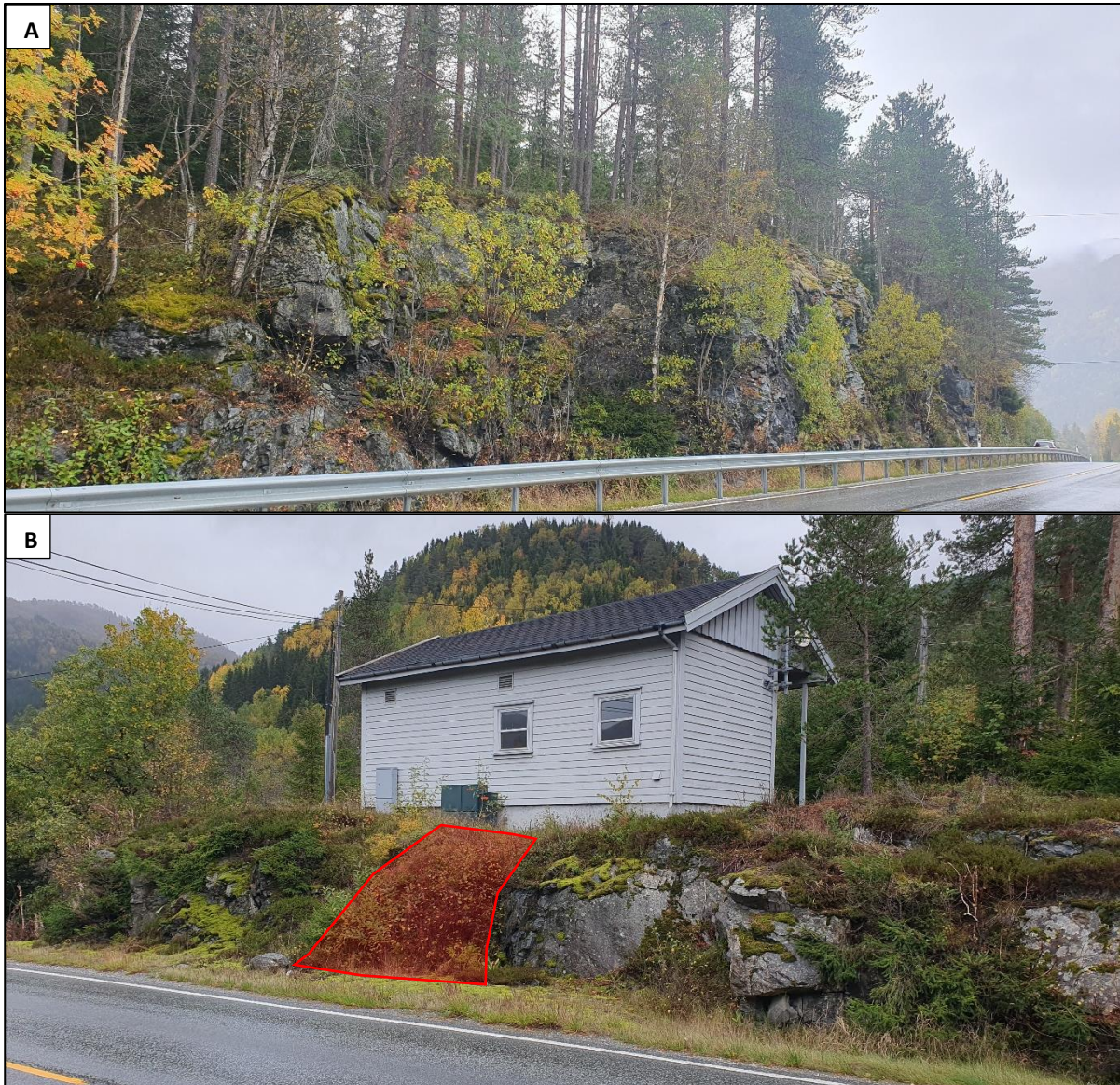
Figur 4: Oversikt over eksisterende bergskjæring. A: E16_Slæn_B02, B: E16_Slæn_B03, bygning på toppen av dagens bergskjæring, ca 2 meter fra skjæringskant. Mulig kabeltrase fra grøft til bygning er vist med rødt.
