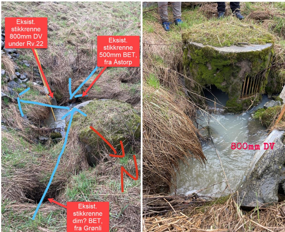
Figur 12. Bilde fra befaring - punkt K4. Innløp kulvert ved Grønli.
