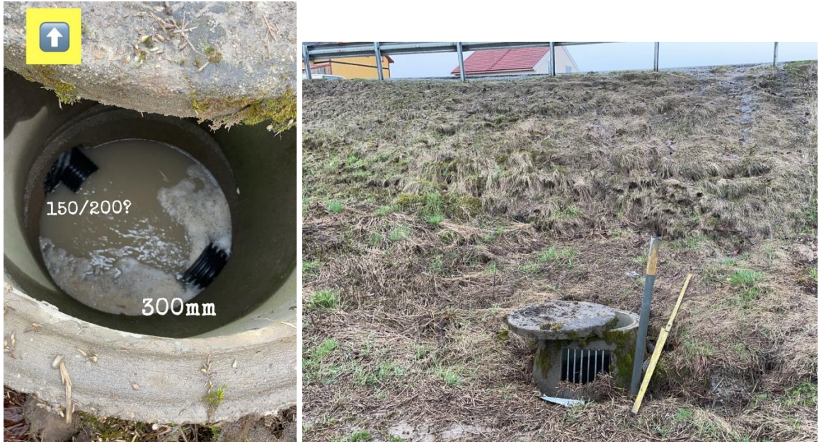
Figur 9. Bilde fra befaring - punkt K1. Inntak kulvert ved Bodal (delfelt 1).
