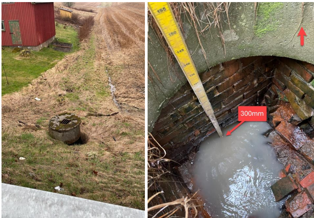
Figur 10. Bilde fra befaring - punkt K2. Utløp kulvert ved Bodal.
