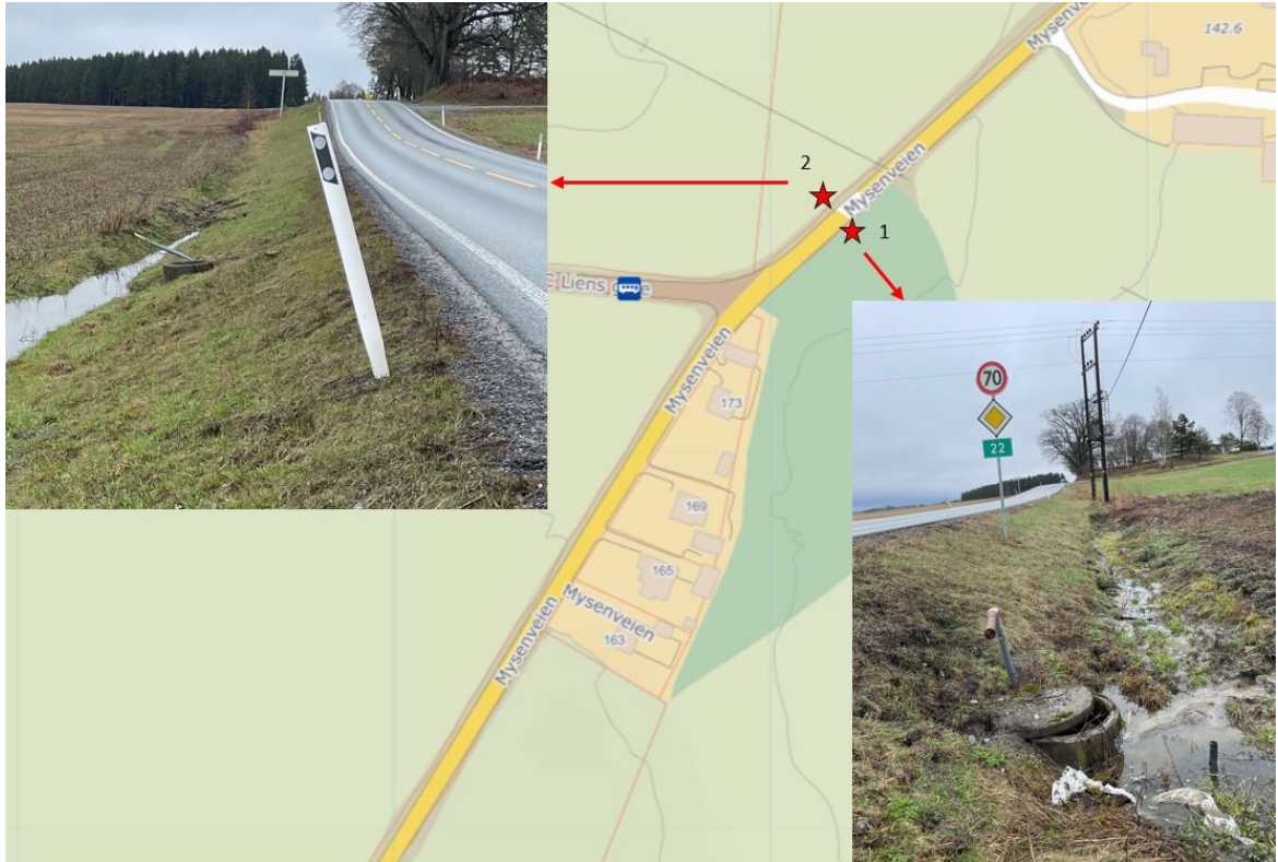
Figur 12. Bilder fra befarings, viser inn og utløp av eksisterende kulvert 1.
