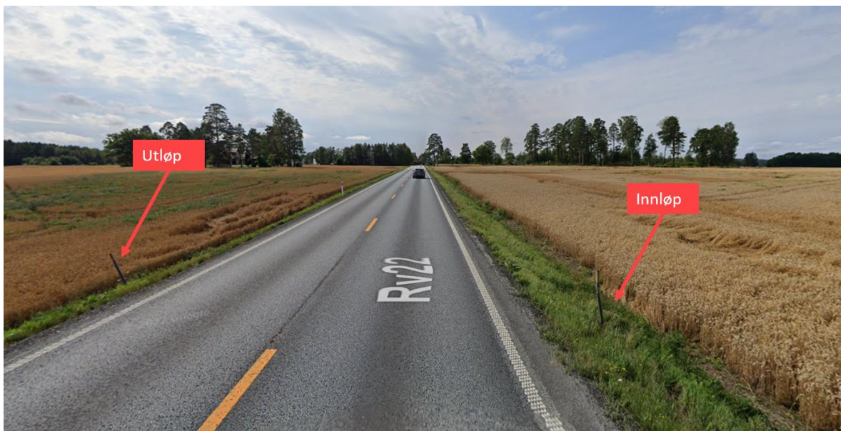
Figur 13. Kulvert 2 fra Google Street view.
