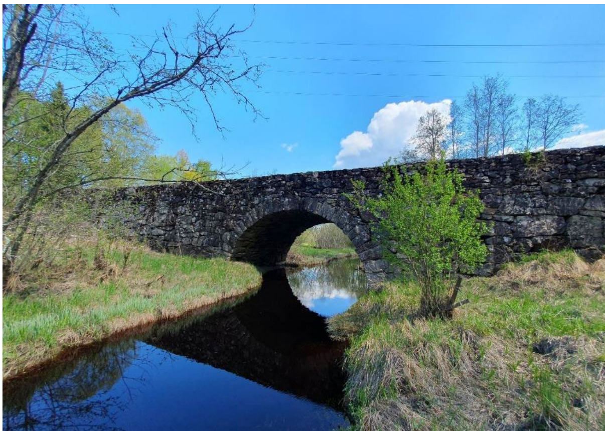
Figur 6-21: Foto av gamle Piksrud bru.
