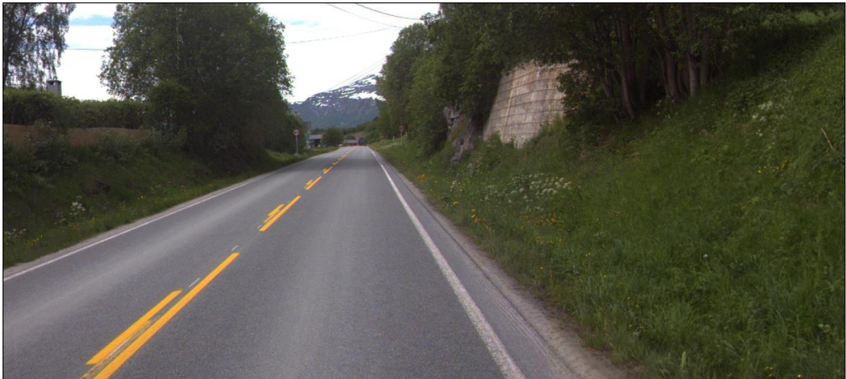
Figur 9: Dagens betongmur ved Ekkerhaugen.
