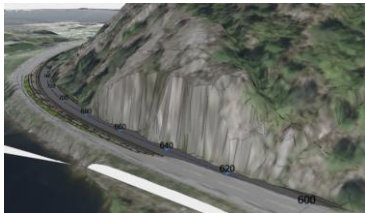
Figur 29 Høg skjæring som kan medføre vegstengning ved sprengningsarbeider
