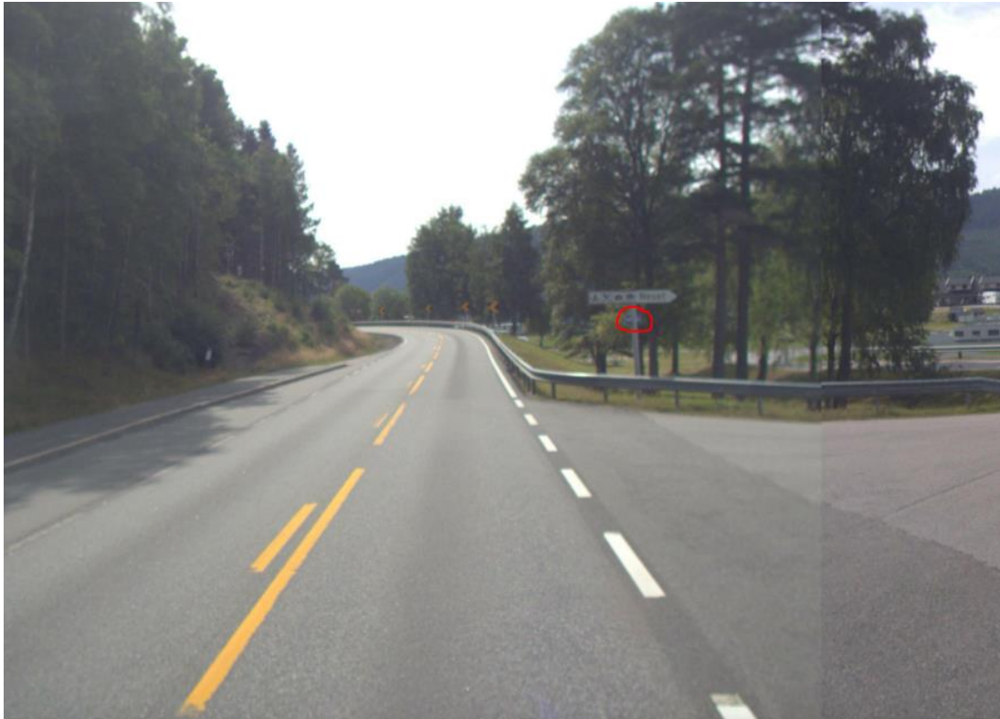
Figur 11 sett mot sør. Foto – statens vegvesen
