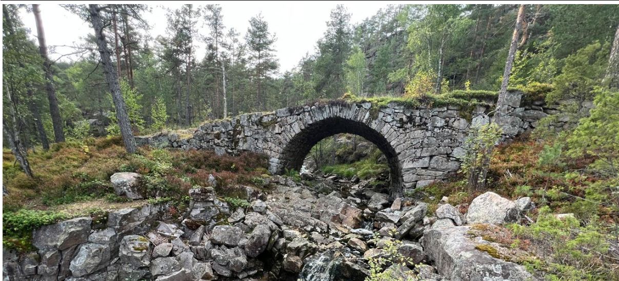
Figur 26 Kiledalskleiva bru. Foto: Øyvind Haugland/SVV
