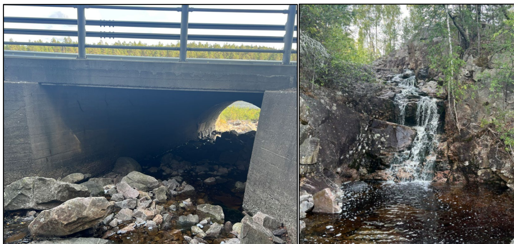
Figur 29 Kiledalen bru ved P880 oppstrøms brua (Foto: Øyvind Haugland/SVV)
