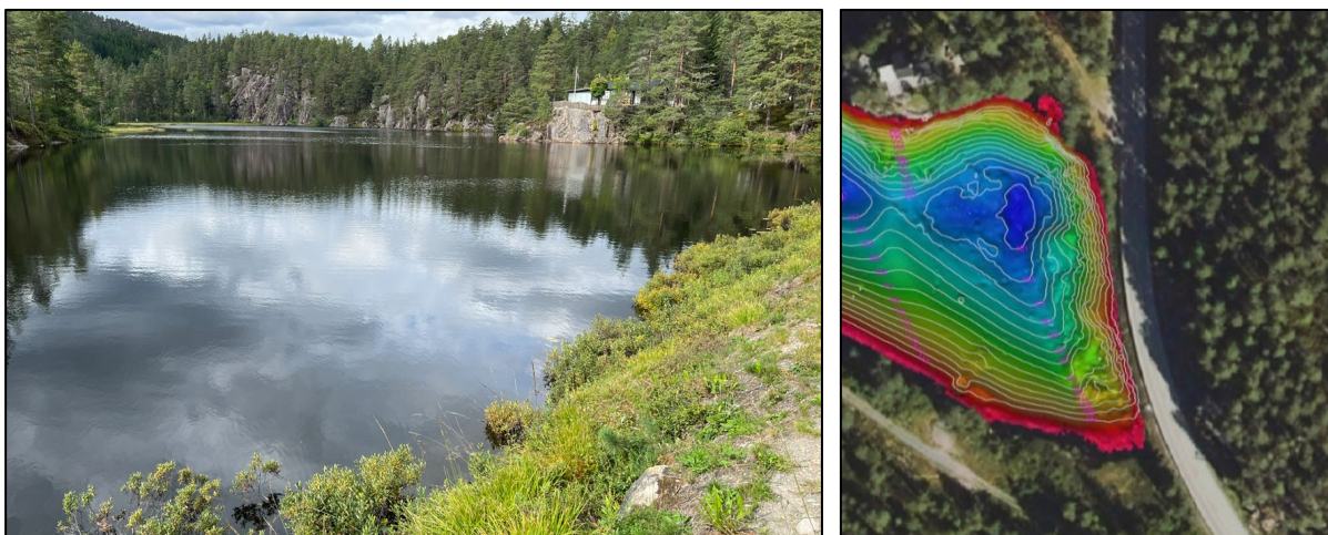
Figur 31 Pederstjønn. Til venstre: vegfylling i forkant av bide. Foto: Øyvind Haugland/SVV. Til høyre: grunnforhold. Rødt er grunnest, blått er dypest.
