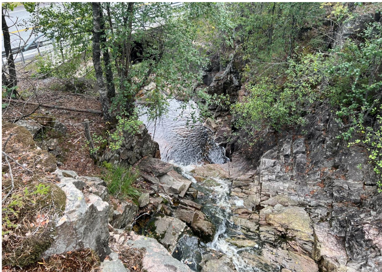
Figur 26 - Eksisterende vannvei til Kile bru / ny stikkrenne
