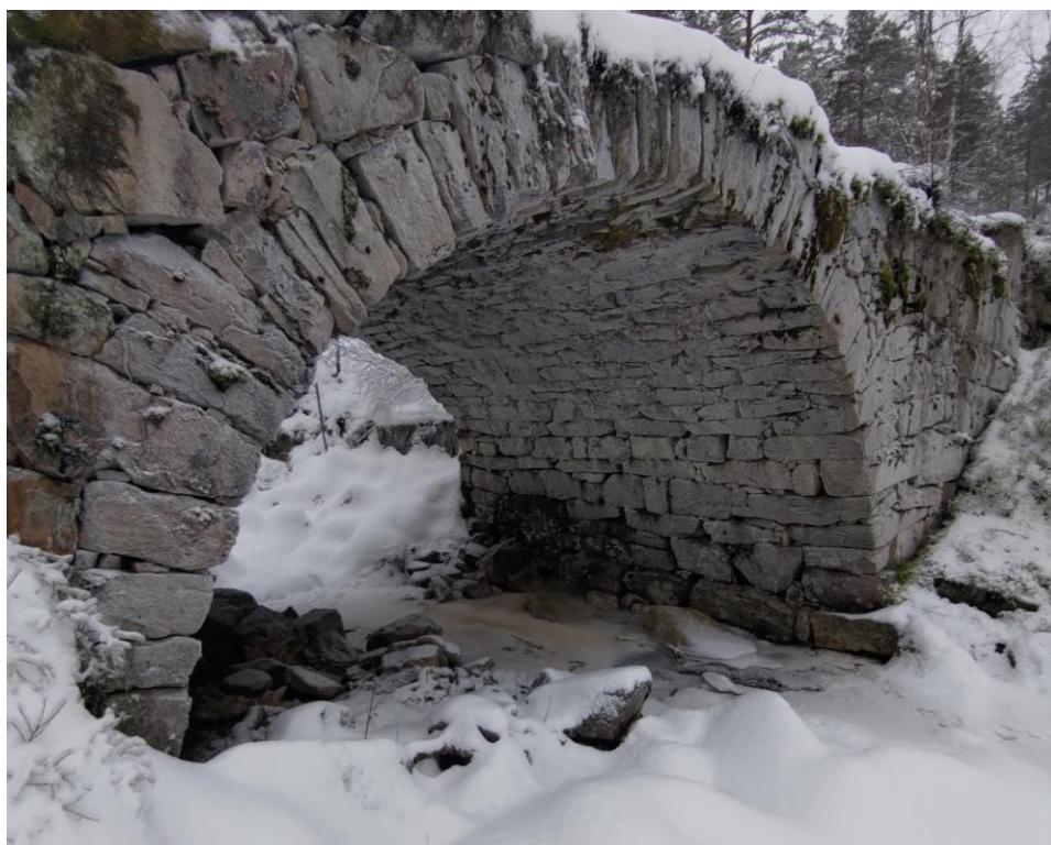
Figur 27 - Steinbru oppstrøms SR080
