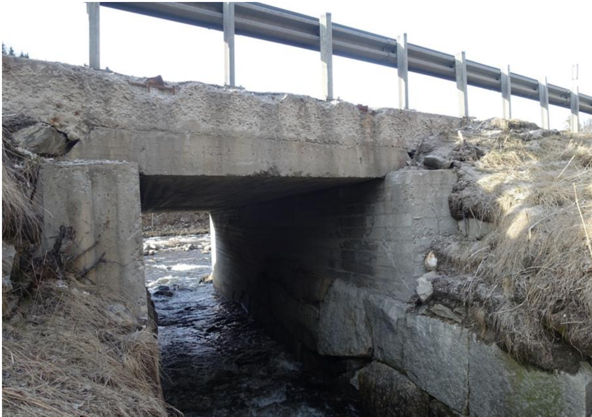
Figur 22: Vangbekken bru med utløp i Tunna ved Midteng, Dagens kapasitet er tilstrekkelig for flomhendelse med 200-års gjentakintervall.
