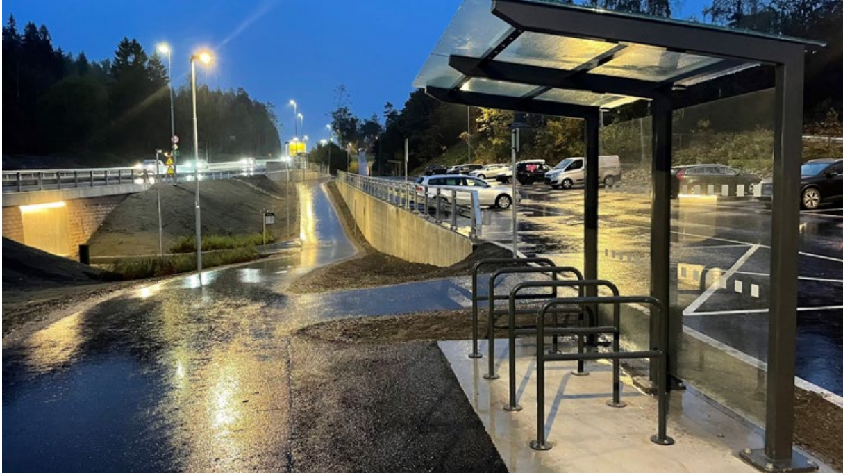
Figur 2: Rv 4 Innfartsparkering, kollektiv- og G/S-tiltak Gjelleråsen foto; Statens vegvesen
