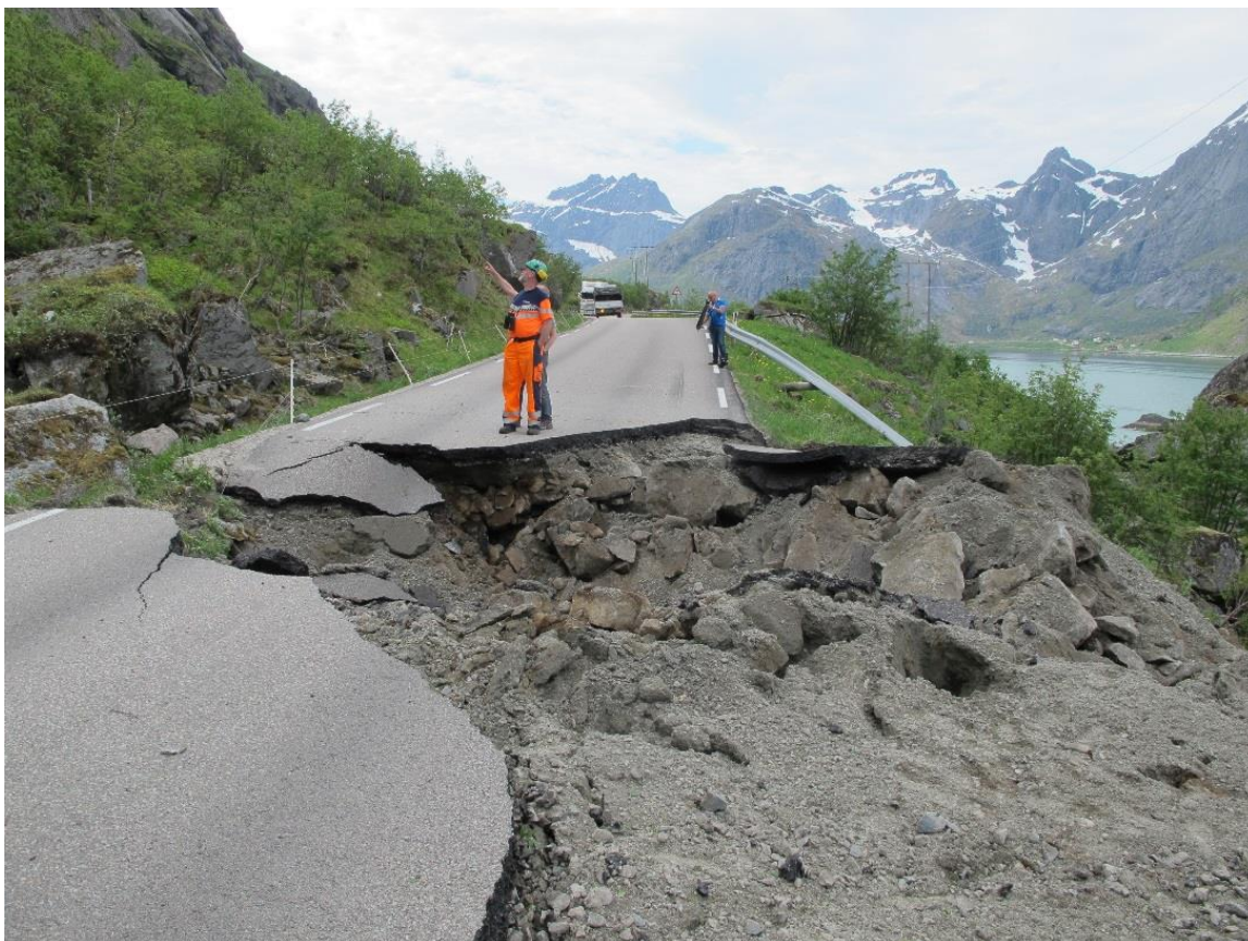
Steinskred ved Flakstadpollen juni 2014.
