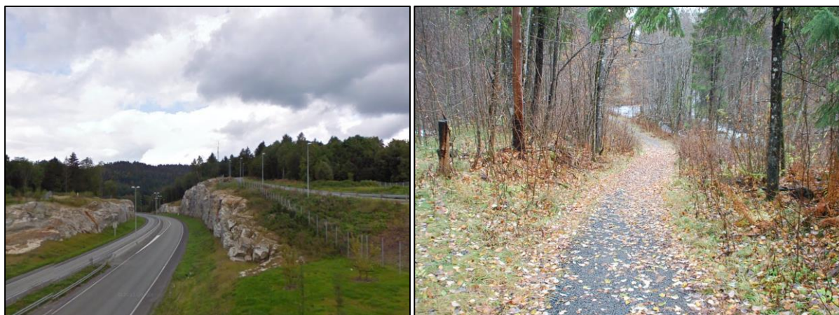
Figur 32 T.v. Fornmindefelt Isi (I skogen til høyere for skjæring og lokalveg). Foto: finn.no. T.h. Turveien langs «Gamle Ringeriksvei». Kilde: CoRa 2018.
