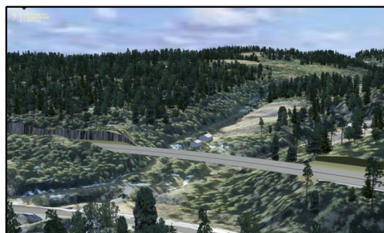
Figur 21: Kryssing av Brubonnsdalen på bru.
