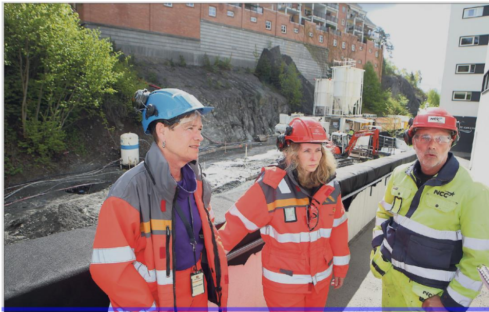
REAGERER: Under arbeidet med nye E16 i Sandvika kastet en nabo en tom konjakkflaske ned fra Kjørbokollen og på arbeiderne som jobber med veien. Statens vegvesens Oddrun Vågbo (fra venstre) og Anne-Lise Gilbebo synes det er ille at folk oppfører seg slik overfor anleggsarbeiderne. – Jeg ble helt paff da flasken ble kastet, sier anleggsleder Reidar Moen i NCC. FOTO: KNUF BJERK
