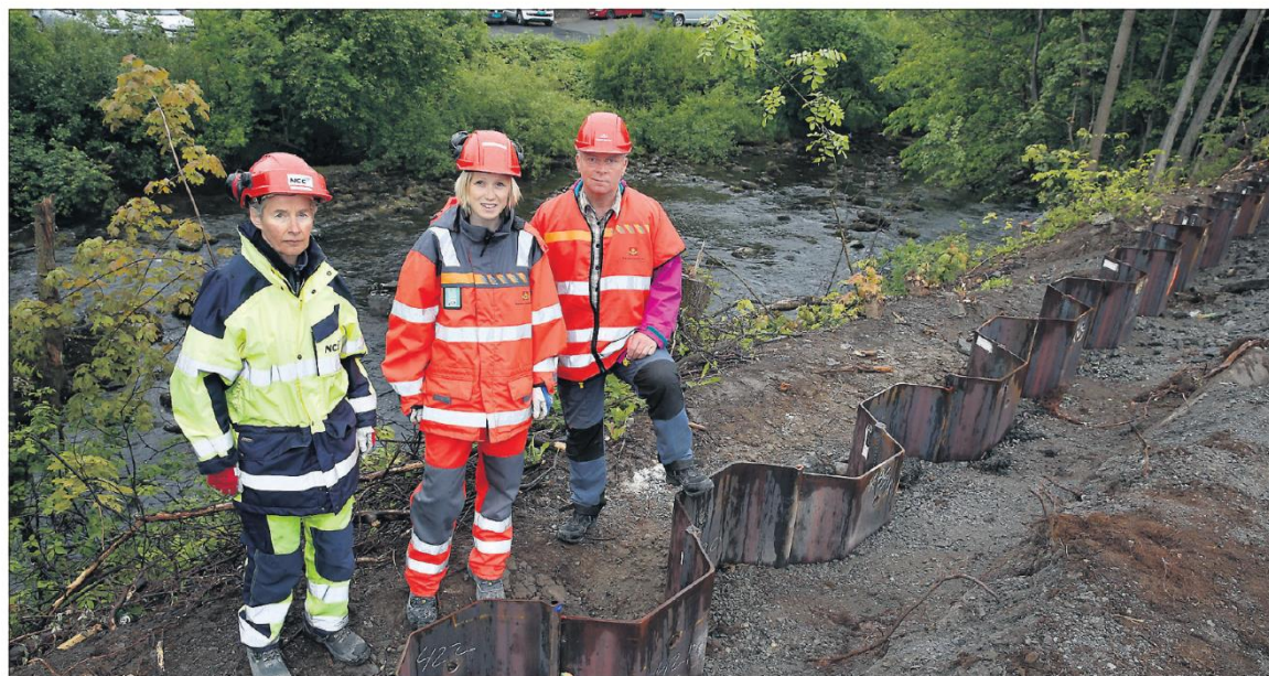
BESKYTTELSE: En spuntvegg er slått ned for å hindre at forurenset masse eller vann siger ned mot Sandvikselven. Kari Aasgard, Silje Nygaard Holen og Morten Merkesdal er enige om at å beskytte miljøet har førsteprioritet ved byggingen av E18 fra Sandvika til Vøyen.
