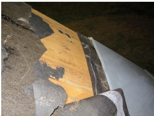
Foto 6. Sørbue, vestre del, ca 3 m fra fundament. Noe nedbrytning i tilknytning til sprekk, ingen tegn til videreutvikling etter 2007.
