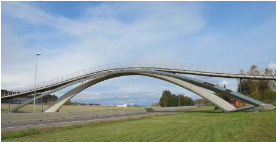
Foto 1. Leonardo da Vinci bru sett fra sør 8. oktober. Det er demontert plater i utvalgte punkter langs nord- og sørbuen.
