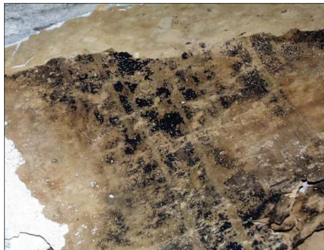
Vekst av Chaetomium på baksiden av papirtapet. Tapetet hadde vært utsatt for høy fuktighet over lengre tid. Det kan være vanskelig å oppdage forekomst av Chaetomium på tapeter fordi den ofte trives best på baksiden inn mot vegg eller veggkonstruksjonen.
