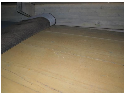
Foto 8. Nordbue, ca 25 m fra vestre fundament. Ingen synlige tegn til råtesoppkader, ingen tegn til nedbrytning ved råtedrilling.
