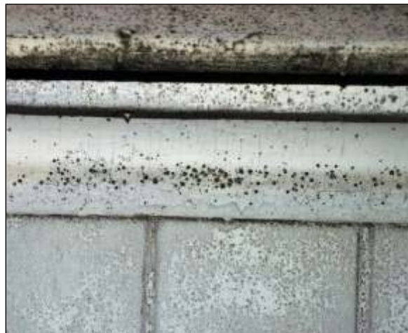
Svertesopp på hvitmalte panelbord.
