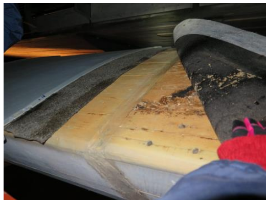
Foto 7. Sørbue, vestre del, ved skjøt ca 19 m fra fundament. Ingen synlige tegn til nedbrytning.
