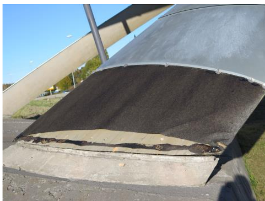
Foto 2. Sørbuens østre fot. Beslaget er løst for kontroll av trematerialene.
