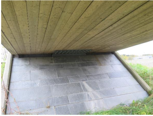
Foto 12. Brubane, ende mot vest sett fra undersiden. Ingen synlige tegn til råtesoppkader.
