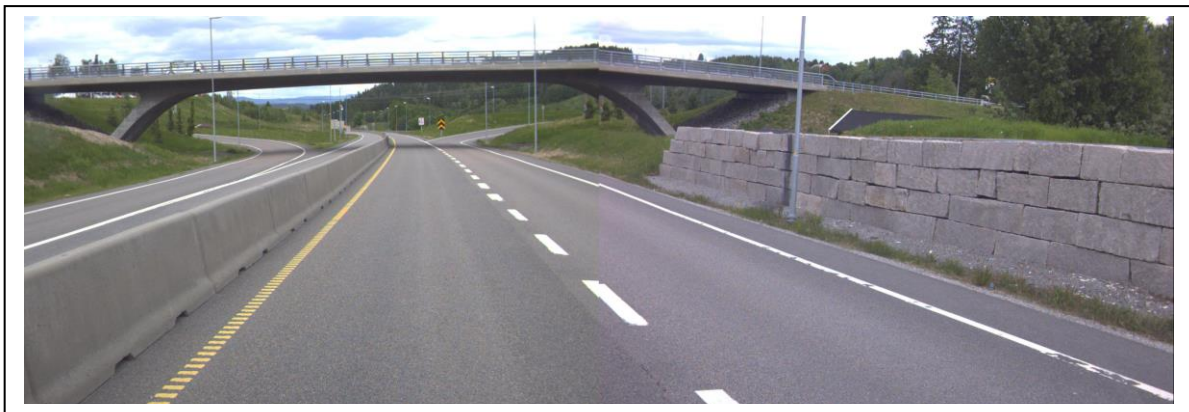
Figur 1 Eksempel på planskilt kryss. Nygårdskrysset sett fra nord mot sør. Ramper kobler kjørende til / fra lokalvegssystemet til Ski, Nordby og bensinstasjonen. Fv. 154 Nordbyveien krysser i bru over E18. Kilde: Statens vegvesen
