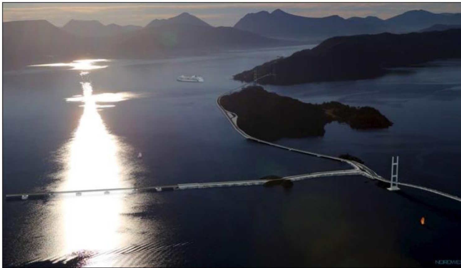
ALTERNATIV: Romsdalsaksen sett mot sør, med Sekken bak til høyre, deretter Veøya og nærmest ei bru over til Åfarnes (til venstre) og Sølsnes mot høyre. FOTOMONTASJE: ROMSDALSAKSEN AS/NORDWEST3D
