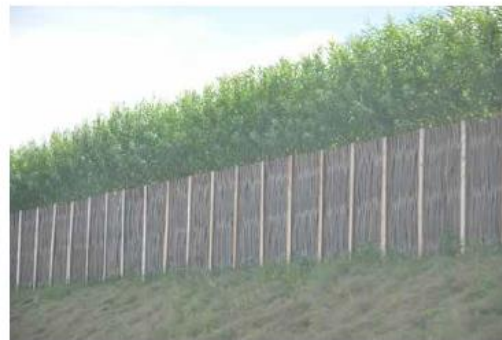
Støyskjermer i pil. Her er det plantet trær bak skjermen, dette er med på å bryte opp inntrykket av støyskjermen. Hvis trærne i tillegg er i ulike arter og høyder vil dette bidra til å bryte opp inntrykket ytterligere. Foto: Kjell Wold
