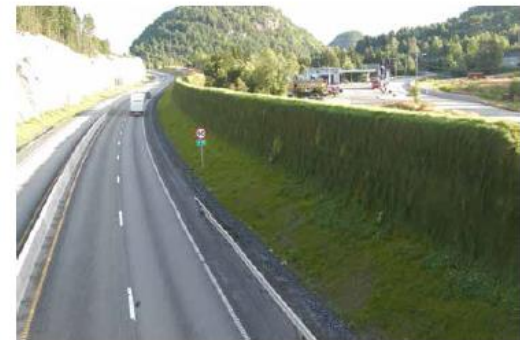
Grønne støyskjermer ønskes brukt på strekningen, her fra E18 ved Akland i Risør. Foto: Kjell Wold.
