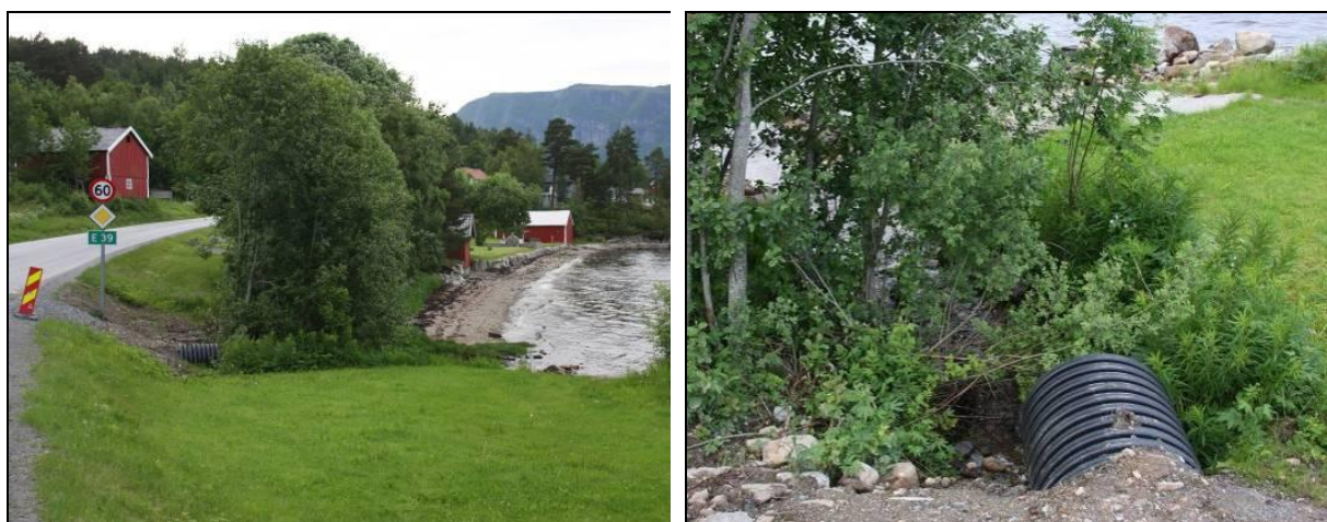
Figur 26. Torbugbekken like vest for fergekaia hadde den 13. juni 2011 nyleg blitt lagt i røyr under E39-vegkana. Denne løysinga hindrar oppgang av anadrom. Foto: Ole Kristian Spikkeland.
