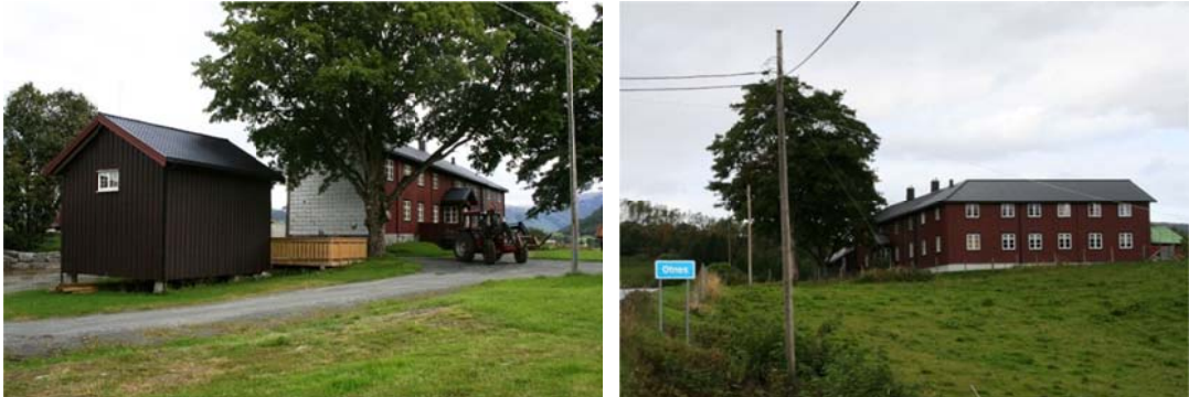
Gardstun på Otnes, Gbnr.104/6, våningshus med kjerne frå 1600-talet. Foto: GMS
