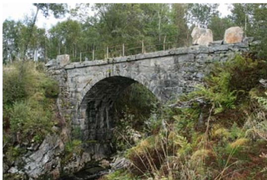
Steinkvelvsbru over Klettaelva. Foto GMS.
