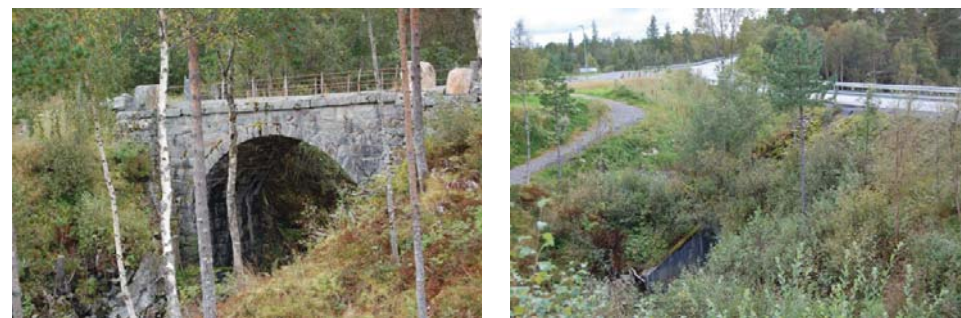
Fig.53: Steinkvelvingsbru og kulvert for Klettaelva. (Foto: IY)
