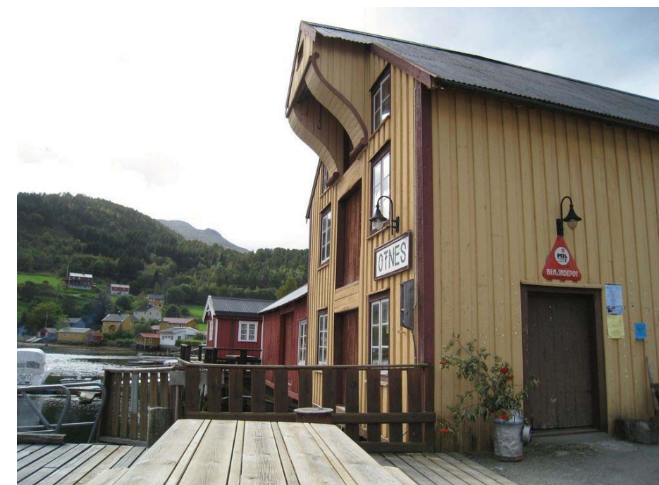
Fig.30: Otnesbryggja. Foto: ASB
