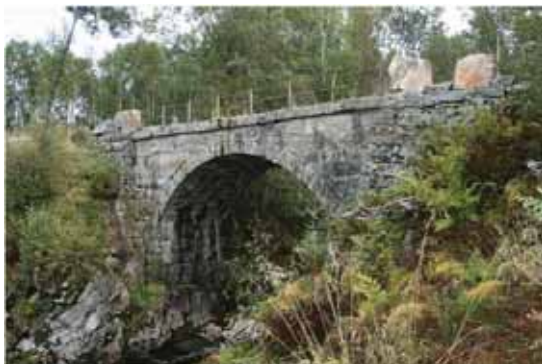
Steinkvelvsbru over Klettaelva. Foto GMS.
