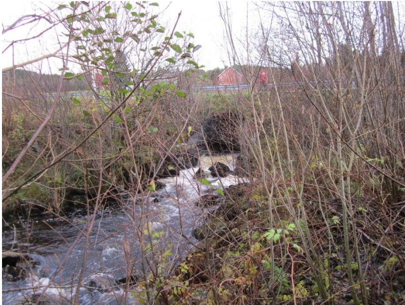
Bildet viser der eksisterande E39 kryssar Stokkelva.( Foto: Torgeir Moen)
