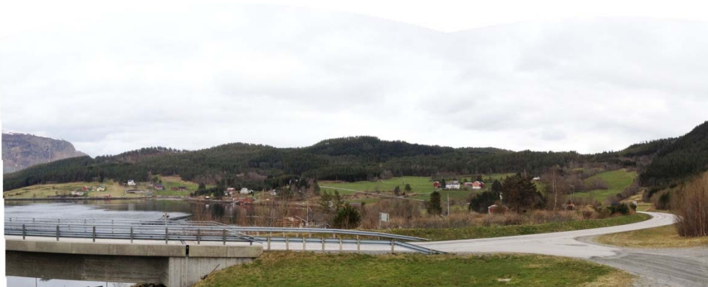
Oversiktsbilde tatt ved Valsøybrua. (Foto: Stig Lillevik)
