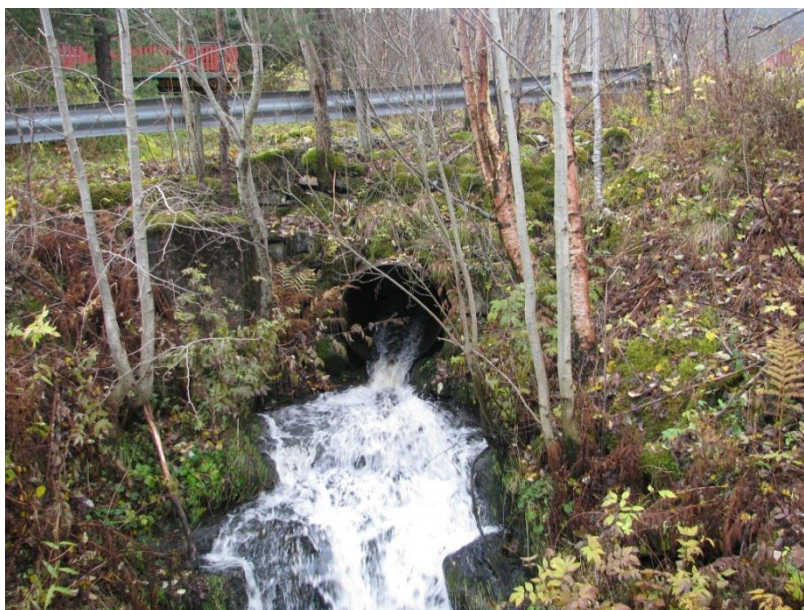
Figur 7 Bekk ved Haukika, oppstrøms fra eksisterende veg (foto: Øyvind Wasmuth)
