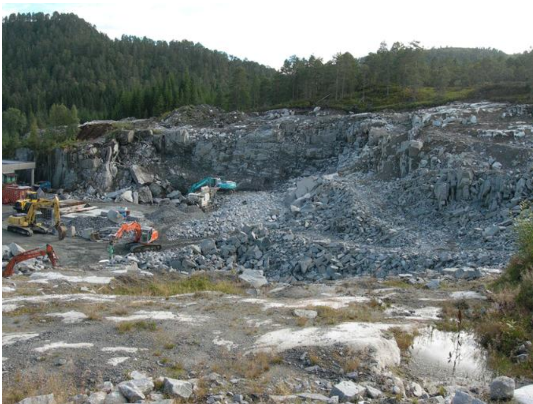
Figur 44 Førde granitt, bruddet sett fra nord ( www.ngu.no ).
