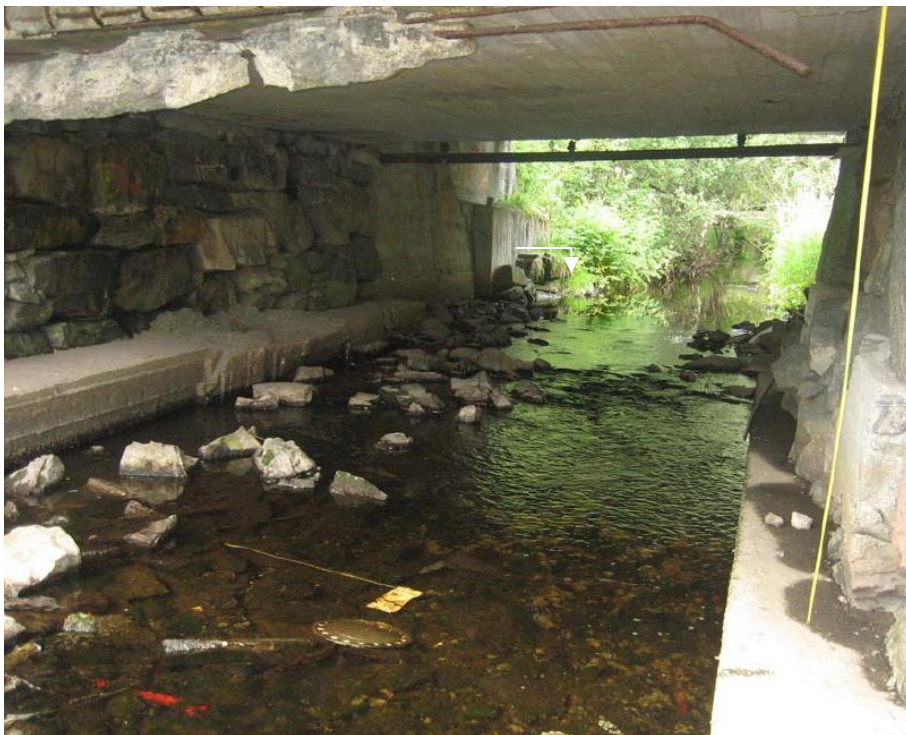
Figur 3-11: Bru under Fv578 ved Coop på Åsamyrane. Bruen er 5 m bred med lysåpning på ca. 10 m 2 .
