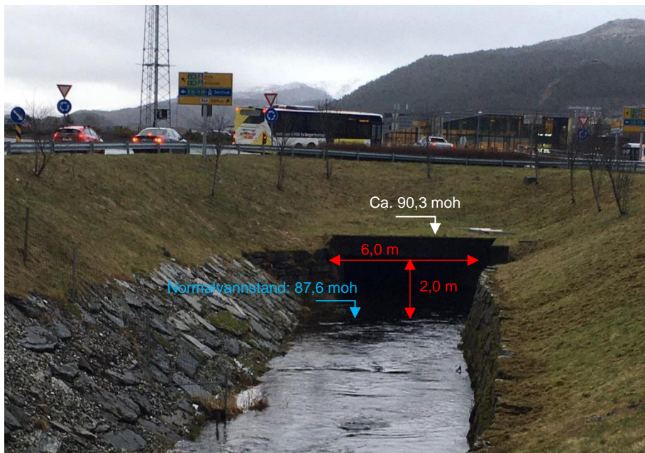
Figur 3-10: Innløpet til kulvert under E39 ved rundkjøring Åsaneveien
