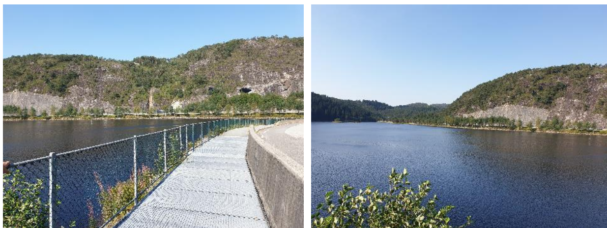
Figur 6-3: Gaupåsvatnet. Foto: Statens vegvesen, august 2019.
