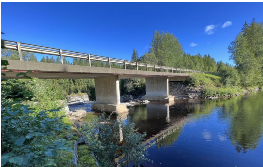
Figur 5-5. Oppstrøms dagens bru, tatt fra sørbredden. Foto: Multiconsult
