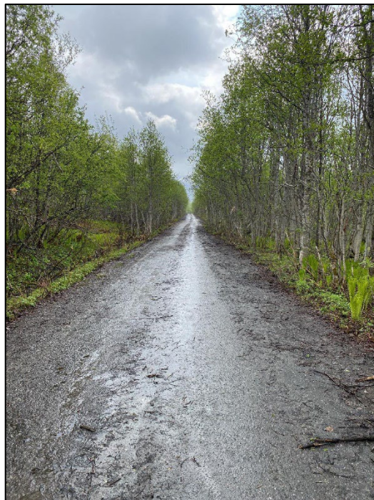
Figur 27. Parti fra gammelveien gjennom Lavangsdalen, mot sør (Foto: Atle Jenssen, Statens vegvesen).
