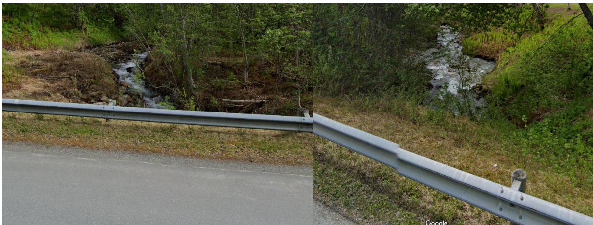
Figur 2.7 Innløp (t.v.) og utløp (t.h.) til stikkrenner i Ørnesveien oppstrøms E8 (Google maps, juni 2022)
