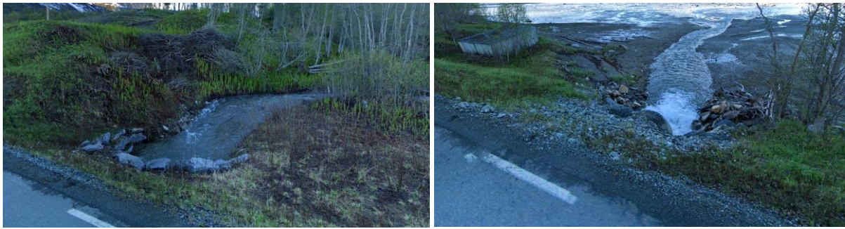
Figur 2.8 Innløp (t.v.) og utløp (t.h.) til stikkrenner i Ørnesveien oppstrøms E8 (Google maps, juni 2022)
